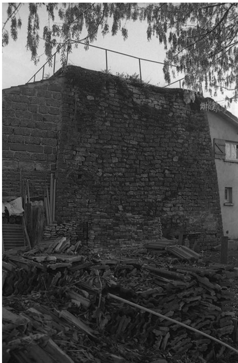
Fours à chaux vus du nord-ouest.
