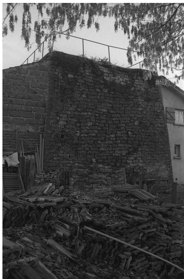
Fours à chaux vus du nord-ouest. Phot. Frédéric Pillet IVR26_19997100887Z
