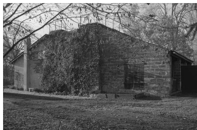
Fours à chaux vus du sud-est. Phot. Frédéric Pillet IVR26_19997100886Z
