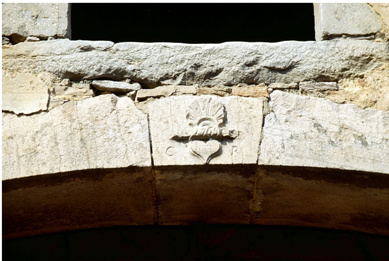
Bâtiment du bureau : clé de voûte sculptée.
