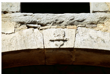
Bâtiment du bureau : clé de voûte sculptée. Phot. Yves Sancey IVR43_19933900148ZA
