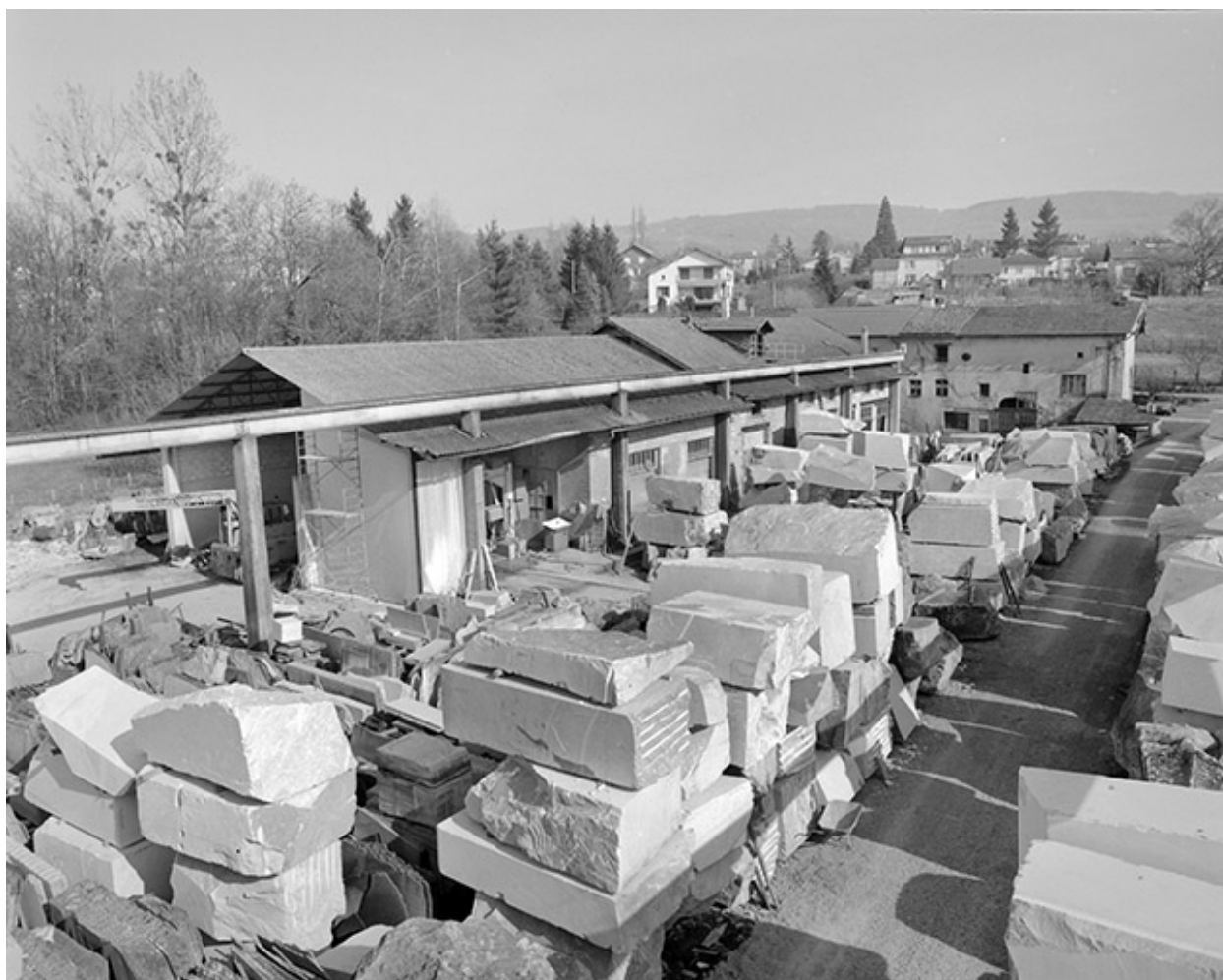
Vue d'ensemble des bâtiments depuis l'ouest.
