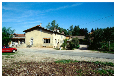
Bureau, atelier de réparation et logement. Phot. Yves Sancey IVR43_19933900145ZA
