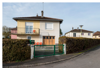
Façade antérieure d'une des maisons. Phot. Jérôme Mongreville IVR43_20187000010NUC4A
