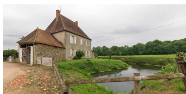
Maison d'habitation et anciennes douve, depuis le nord-est. Phot. Pierre-Marie Barbe-Richaud IVR26_20187100031NUC4AQ
