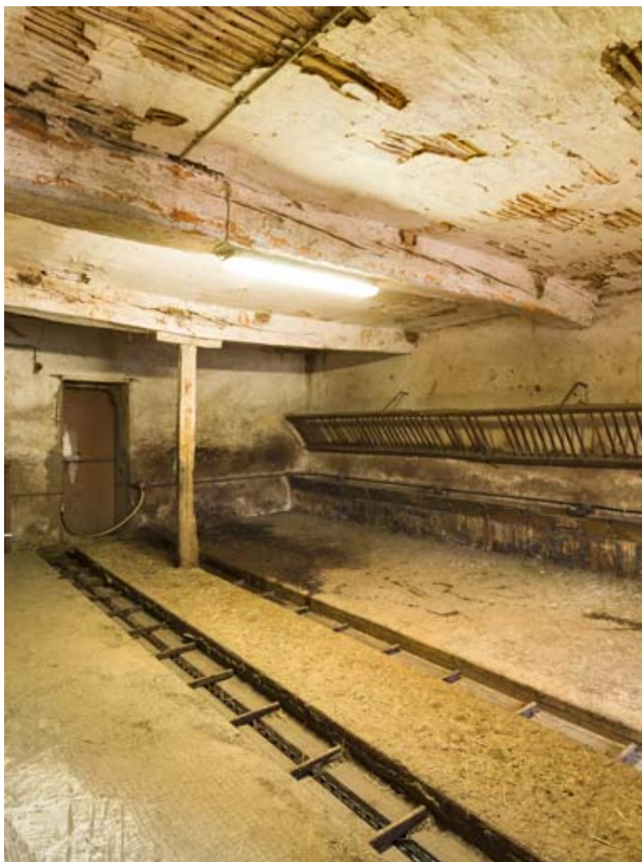
Vue intérieure de l'étable.
