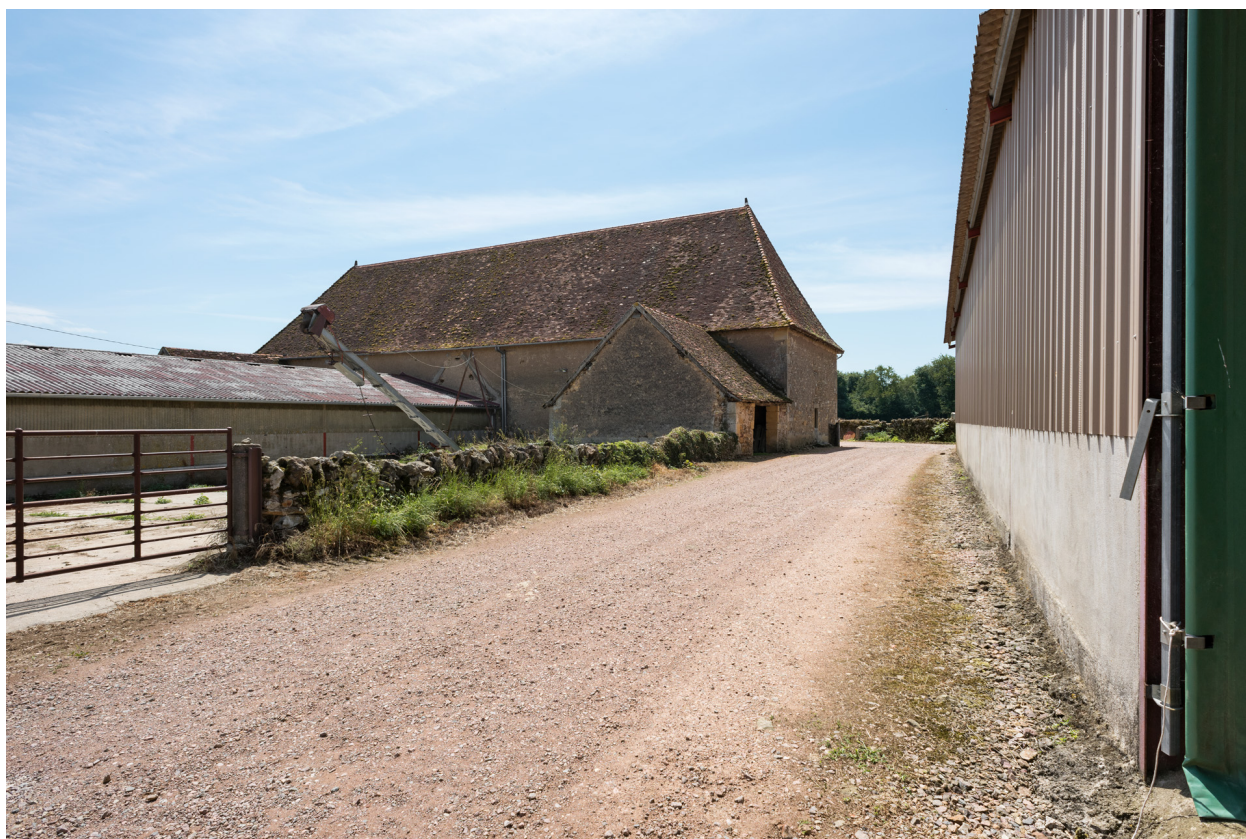
Bâtiment agricole vu de trois quarts arrière.
