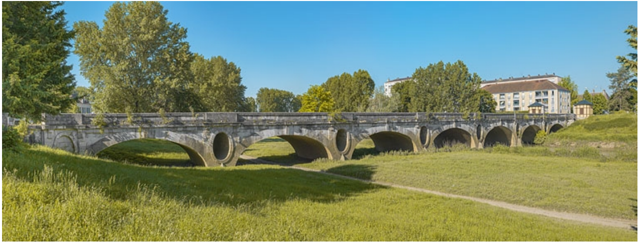
Vue d'ensemble du pont des Chavannes.
