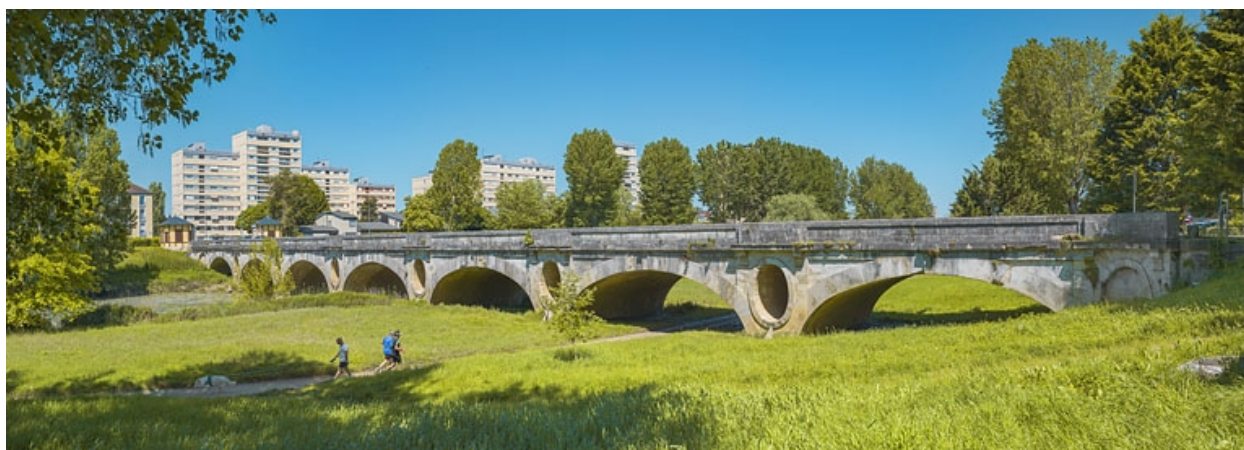
Le pont des Chavannes, vu d'aval.
