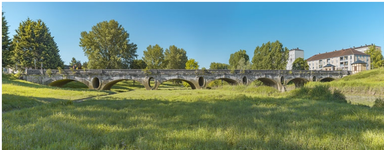
Vue d'ensemble du pont des Chavannes.
