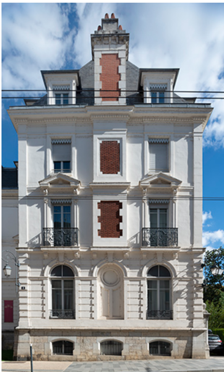
Façade sur l'avenue Carnot, avant-corps de droite.
