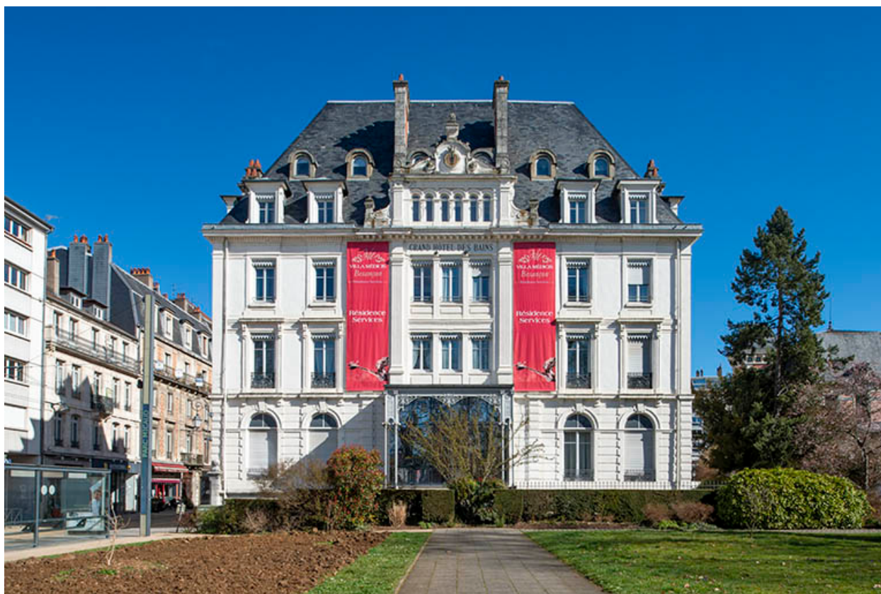
Façade sur l'avenue Édouard Droz.
