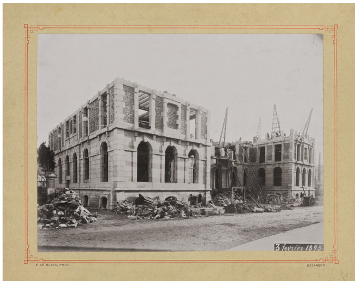
Chantier de construction (3 février 1893).
