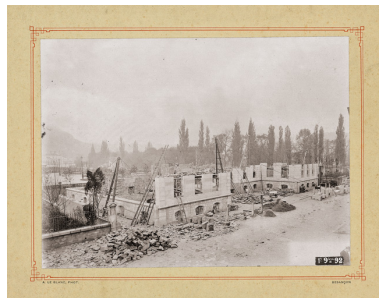
Chantier de construction (1er novembre 1892). Autr. A. Le Blanc IVR43_20232500637NUC2A
