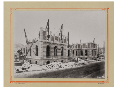
Chantier de construction (3 décembre 1892). Autr. A. Le Blanc IVR43_20232500638NUC2A
