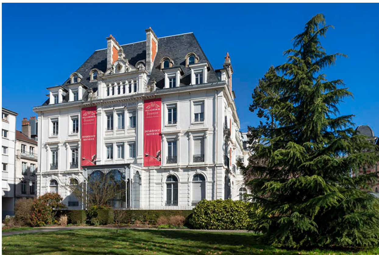
Façade sur l'avenue Édouard Droz.
