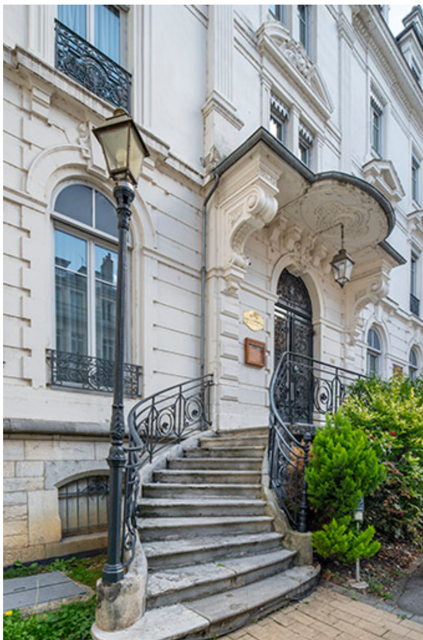
Façade sur l'avenue Carnot, entrée avec perron.
