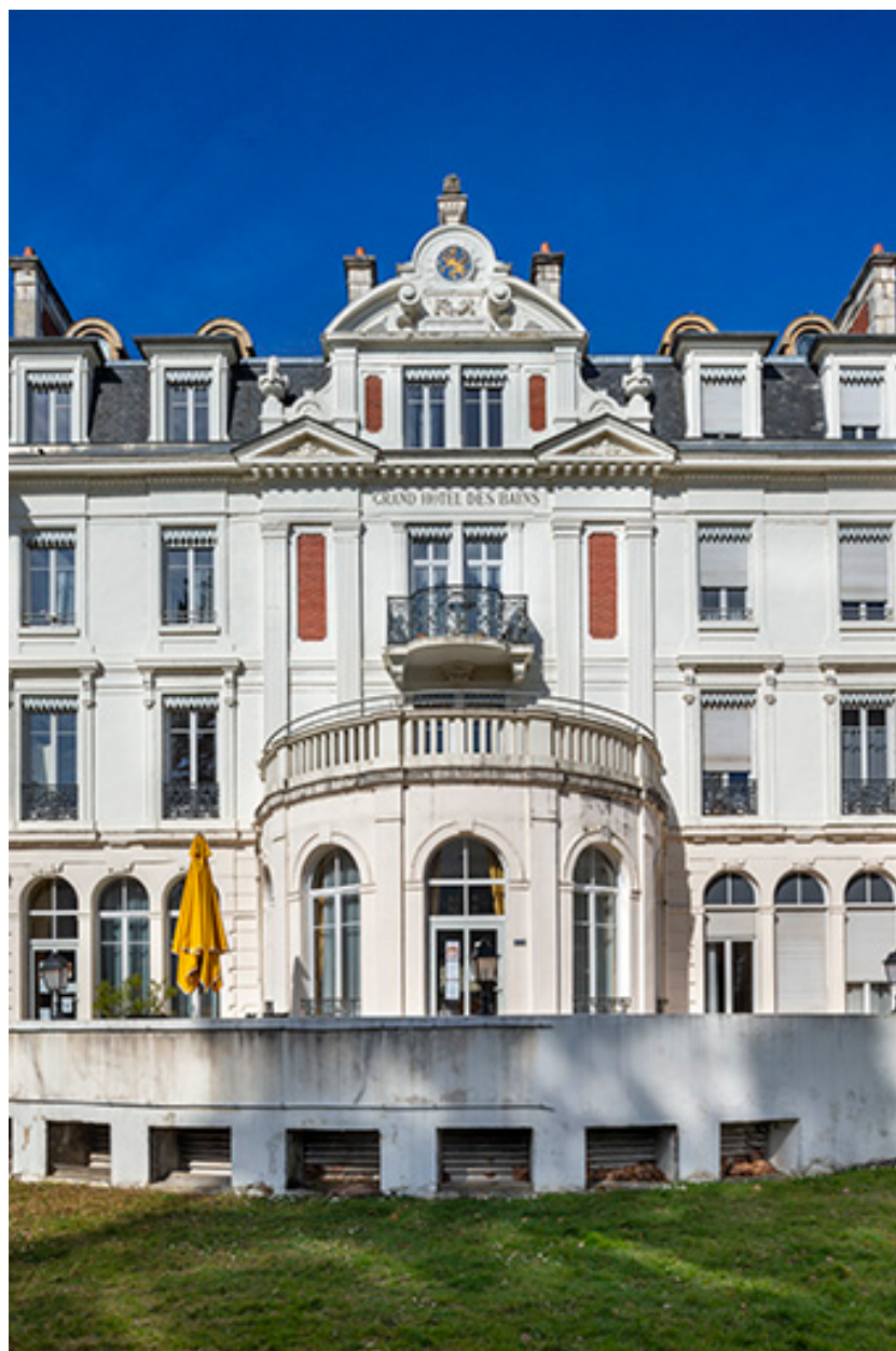
Façade sur le jardin, travées centrales.
