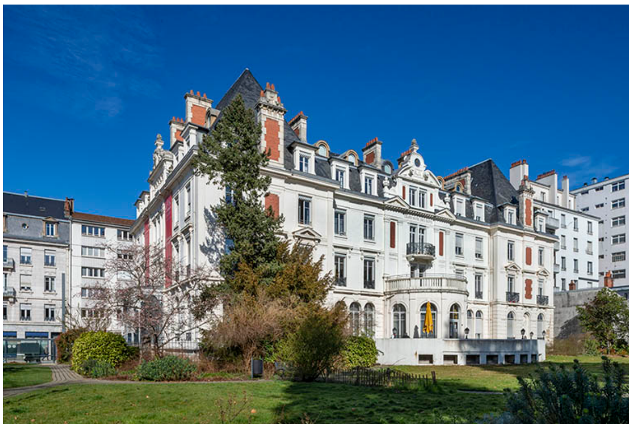
Vue d'ensemble depuis l'avenue Édouard Droz.
