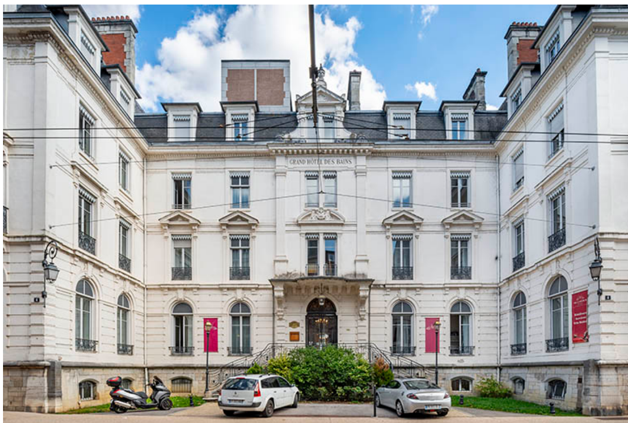
Façade sur l'avenue Carnot.
