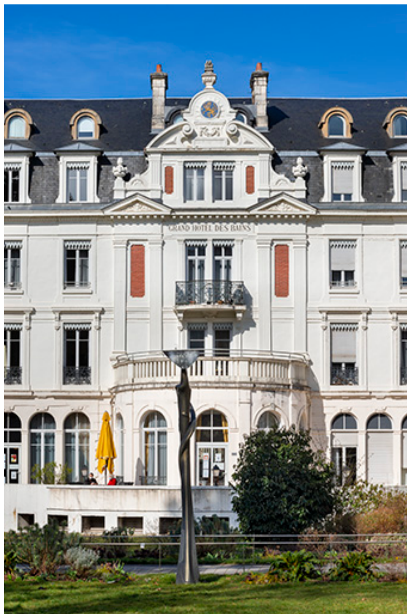
Façade sur le jardin, travées centrales.
