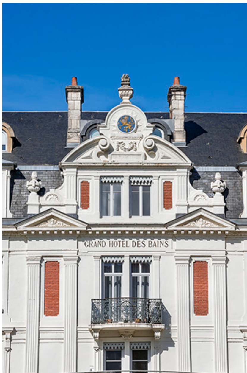
Façade sur le jardin, travées centrales, détail.
