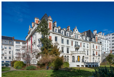
Vue d'ensemble depuis l'avenue Édouard Droz. Phot. Jérôme Mongreville IVR43_20222500555NUC4A
