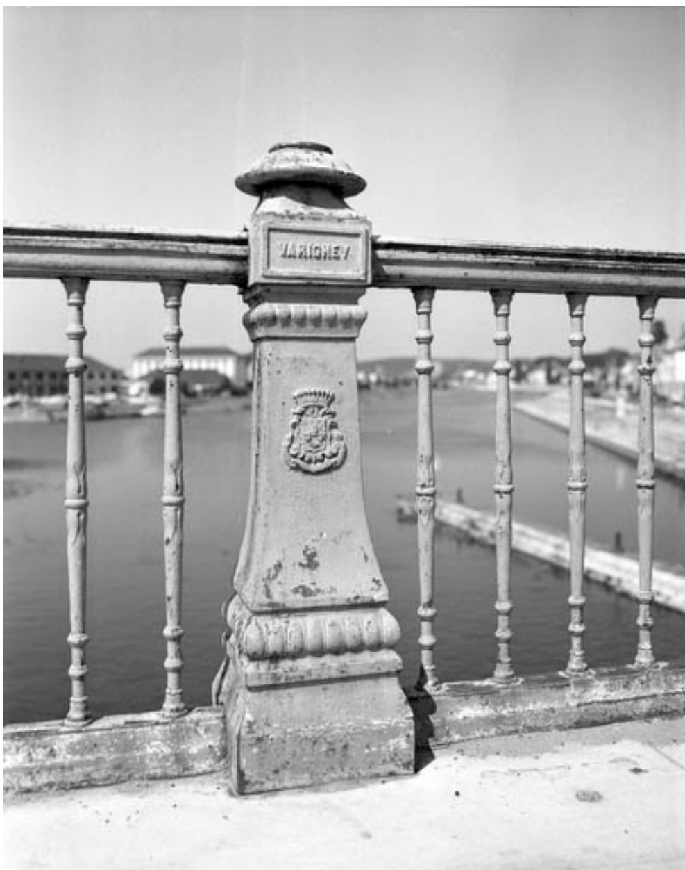
Détail du garde-corps : vue du balustre central.
