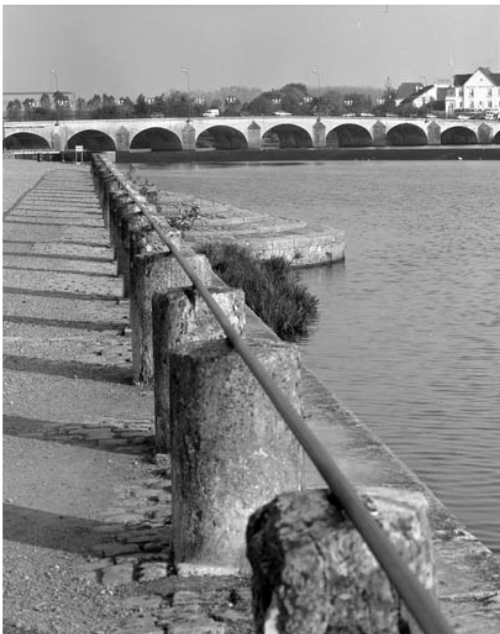
Vue d'ensemble depuis le quai de l'Ecluse.
