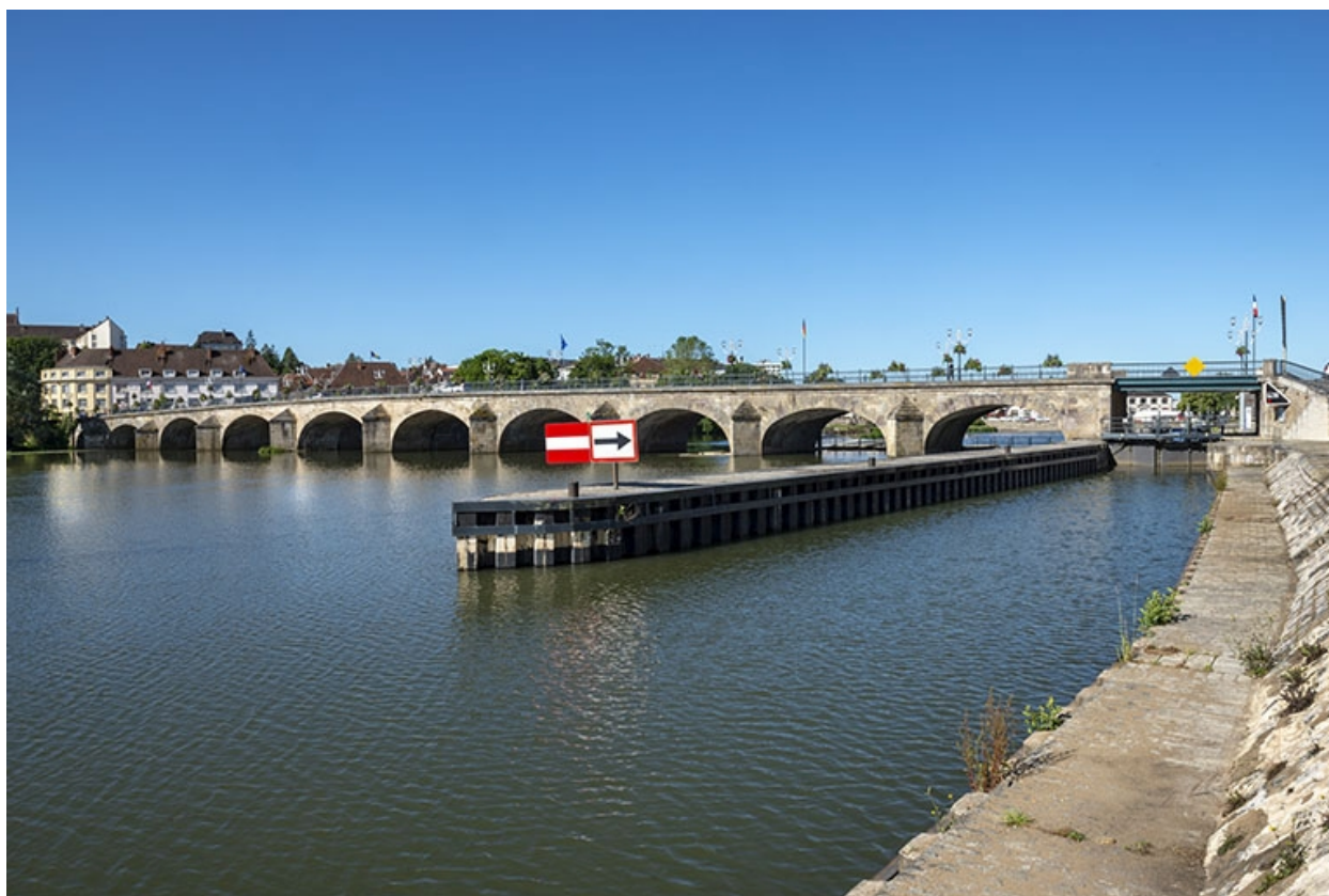
Pont et écluse marinière.
