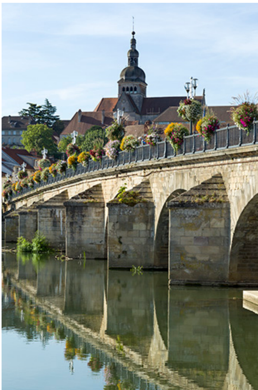
Détail des avant-bec des piles.
