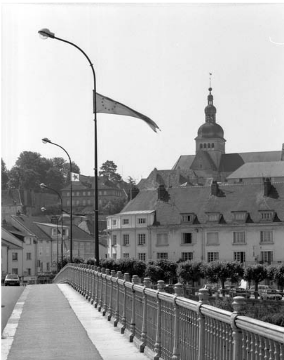
Vue du garde-corps en fonte.
