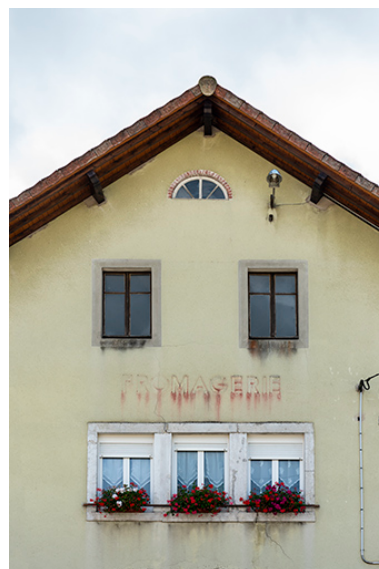
Façade antérieure : travées centrales. Phot. Sonia Dourlot IVR43_20192500905NUC4A
