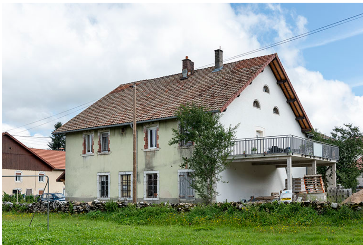
Façades postérieure et latérale droite.
