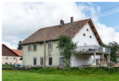
Façades postérieure et latérale droite.
