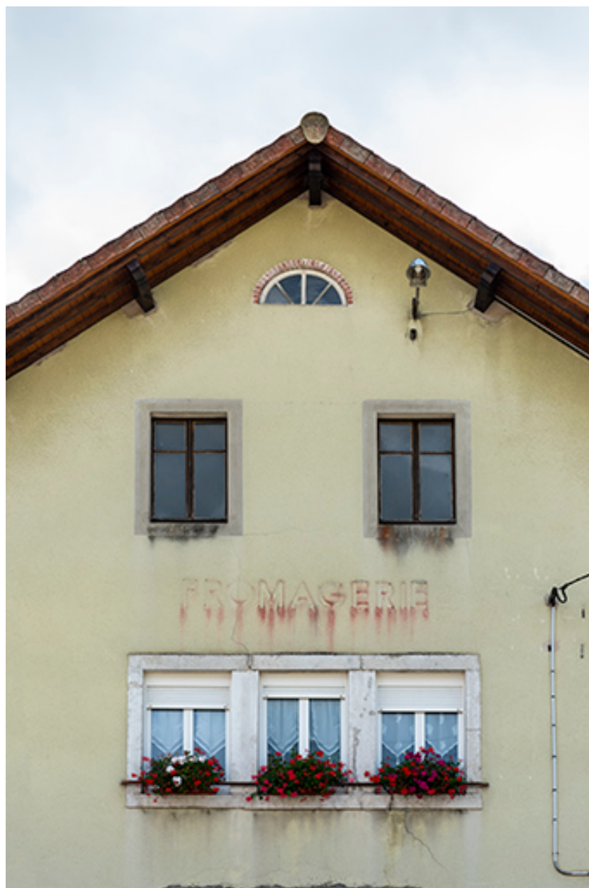
Façade antérieure : travées centrales.
