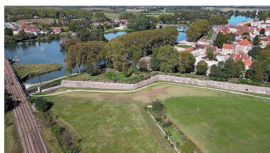
Vue aérienne du demi-bastion. Phot. Sébastien Bardou IVR26_20232100441NUC2A
