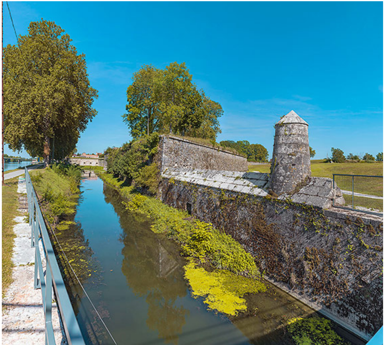
Le bastion et son batardeau.
