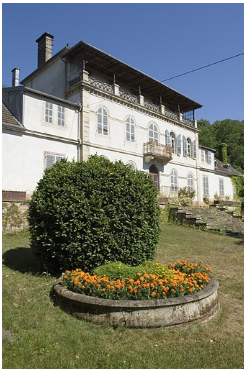
Logement patronal nord. Vue de trois quarts.
