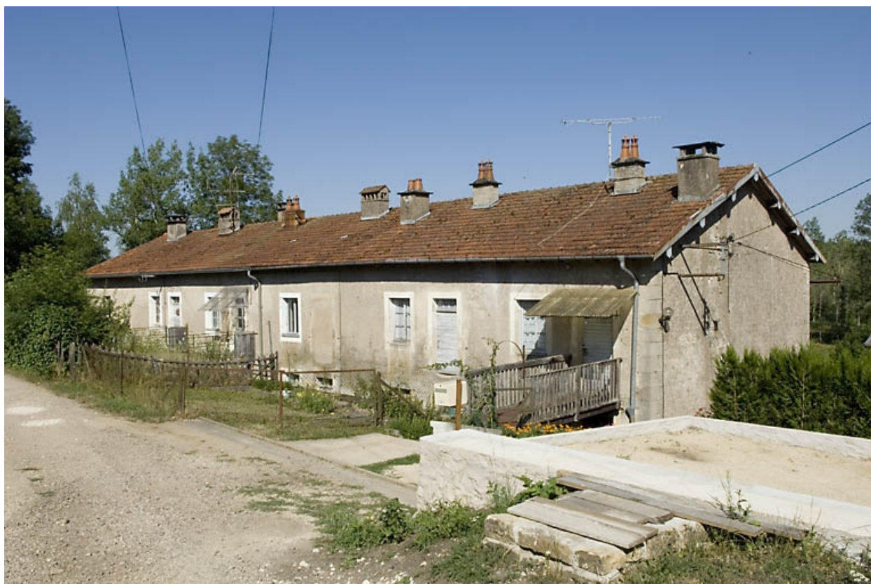
Logement ouvrier collectif (impasse Albert Ricot).
