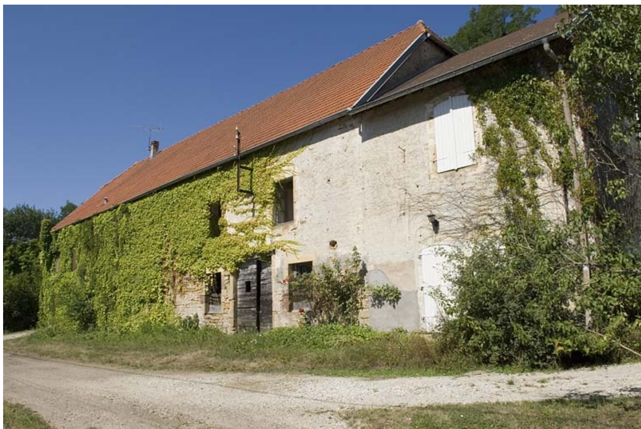
Ancien magasin industriel.
