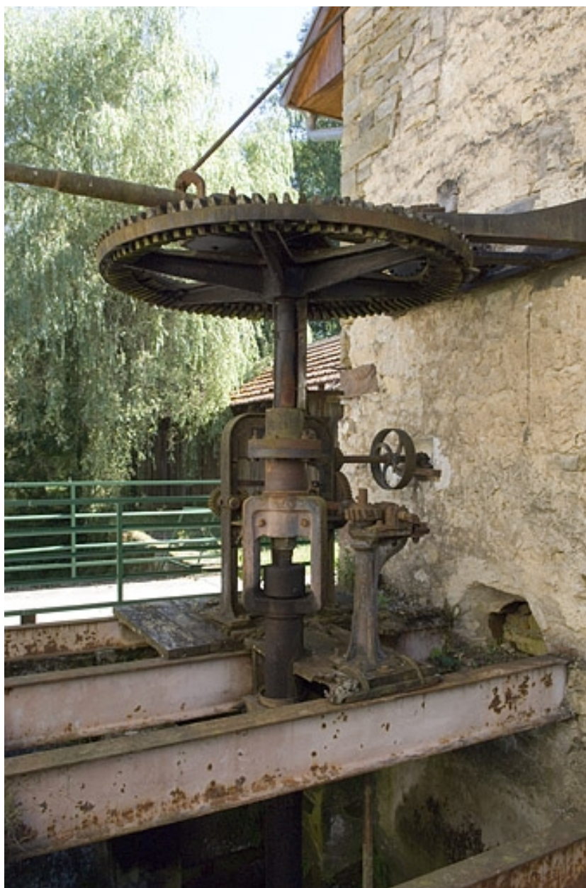
Turbine hydraulique. Partie supérieure de la transmission.
