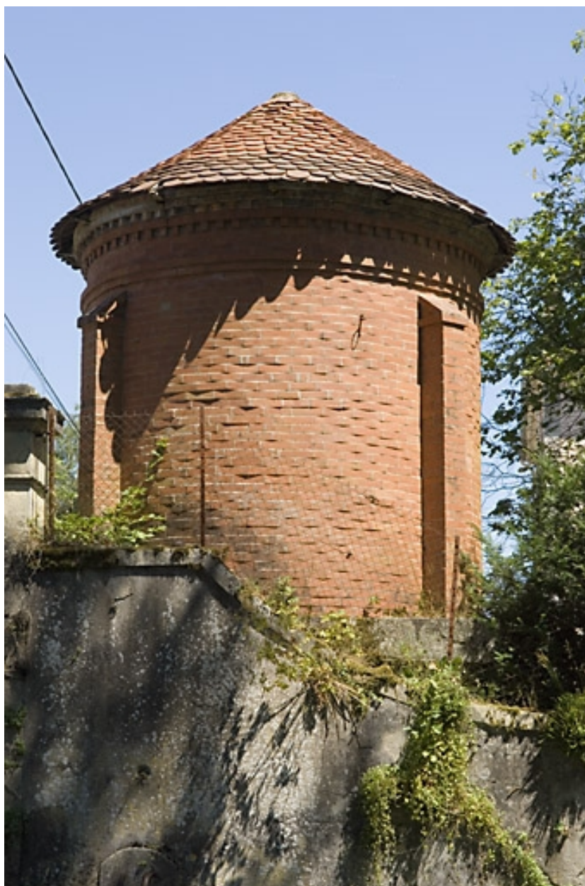
Château d'eau à usage domestique.
