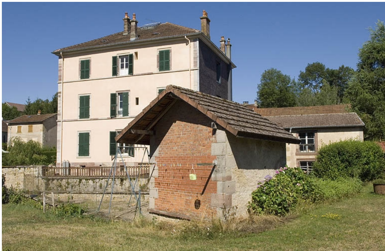
Logement patronal sud. Façade postérieure.
