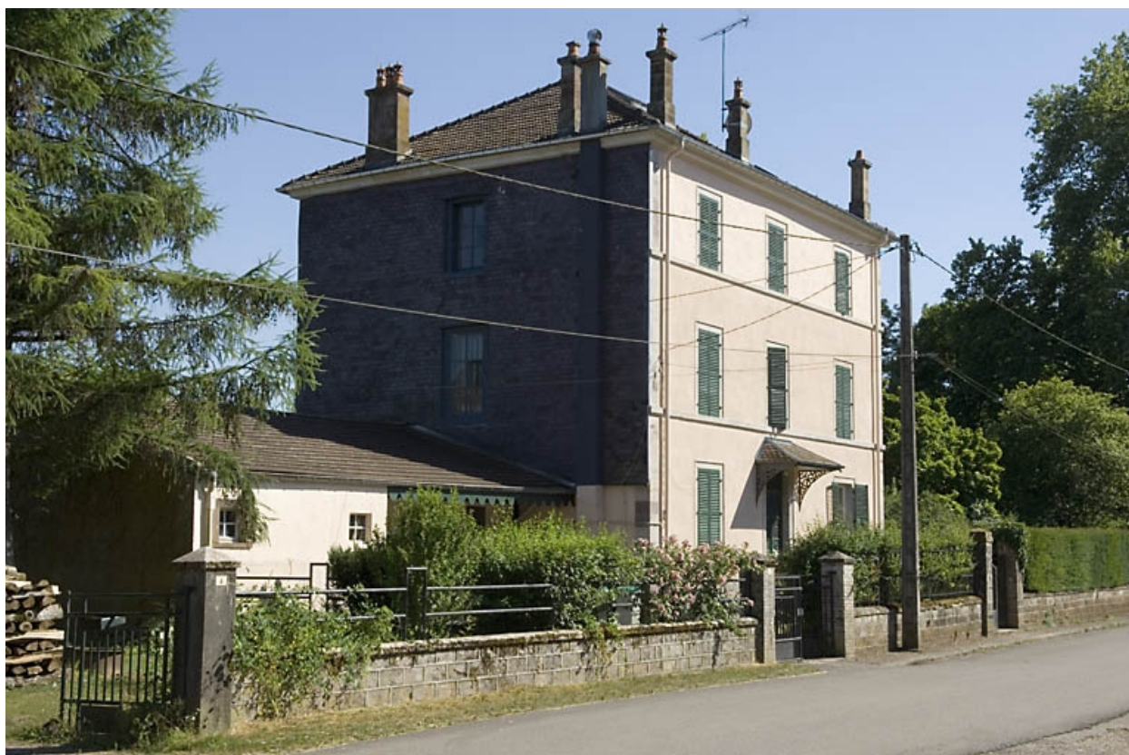
Logement patronal sud. Vue de trois quarts.
