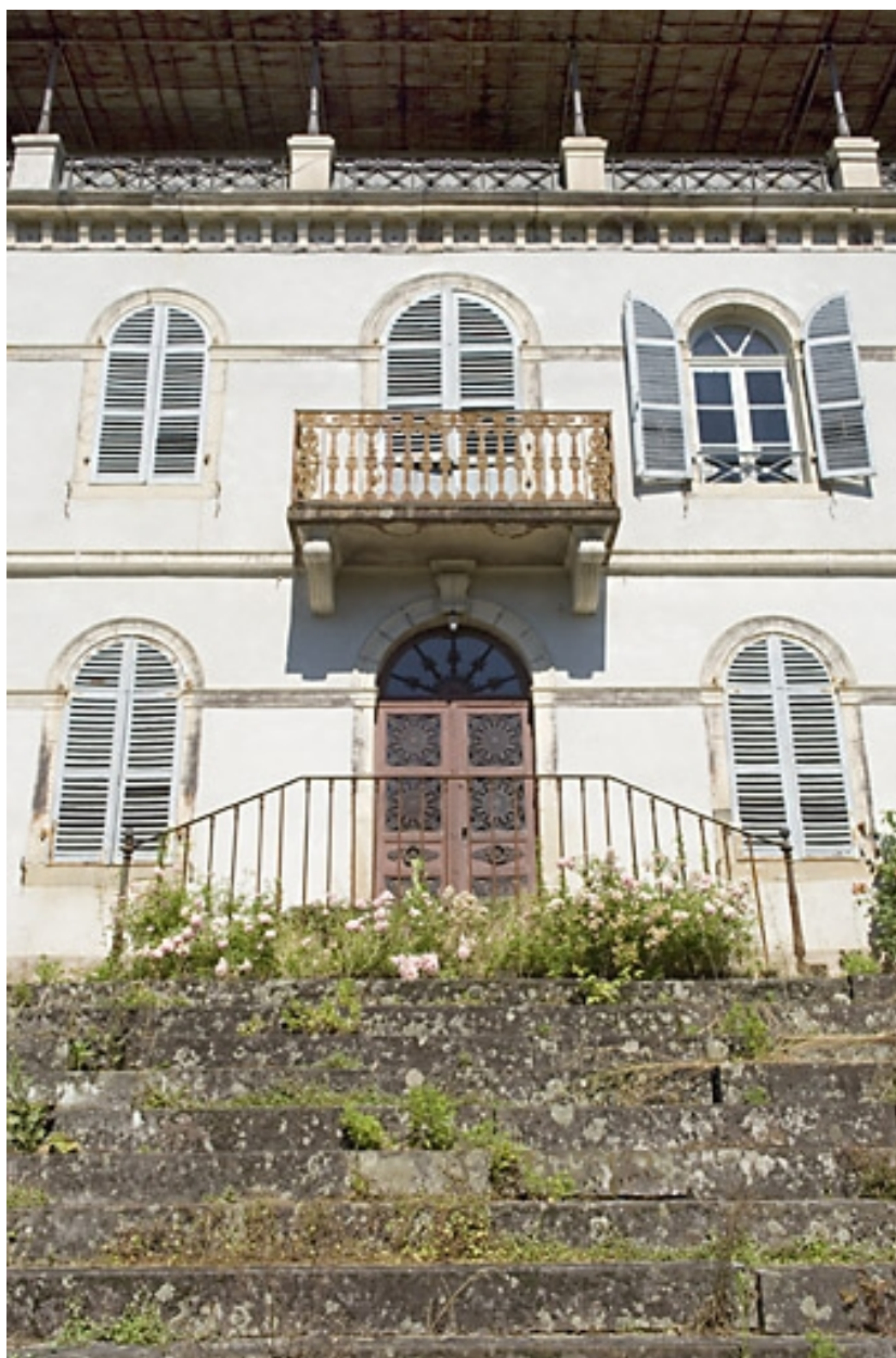
Logement patronal nord. Détail des travées centrales.
