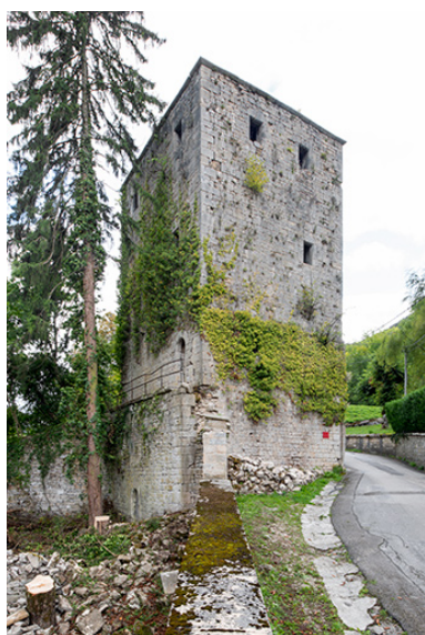
Elévation ouest et sud. Phot. Nicolas Waltefaugle IVR43_20253900175NUC4A
