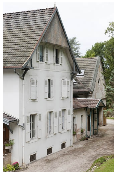
Détail des pignons de la façade postérieure.
