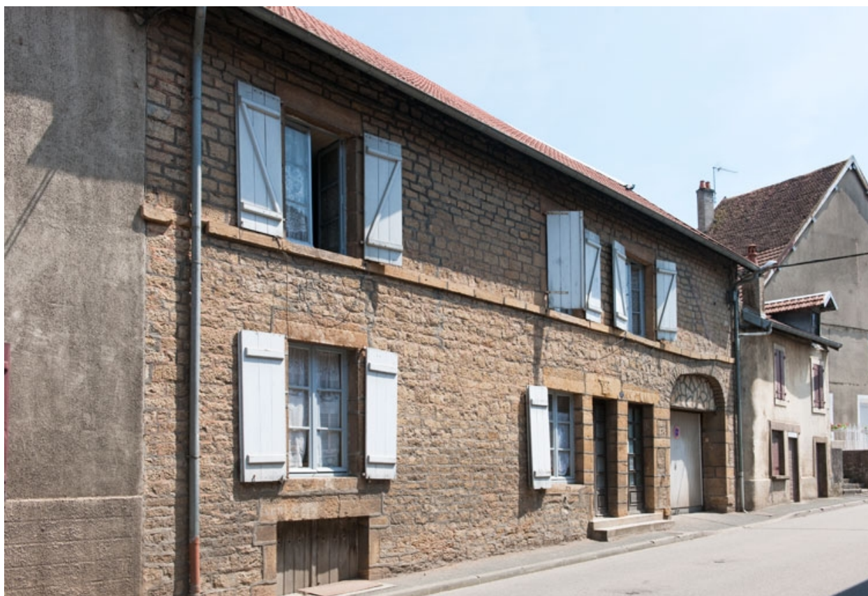
Façade antérieure, vue de trois quart gauche.
