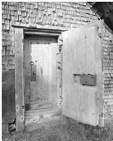
Double porte d'accès du grenier fort. Phot. Jérôme Mongreville IVR43_19963901336X
