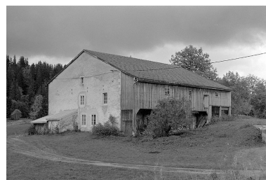
Face nord-est et façade postérieure. Phot. Jérôme Mongreville IVR43_19963901345X
