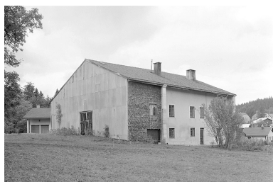
Façade antérieure et face sud-ouest. Phot. Jérôme Mongreville IVR43_19963901332X
