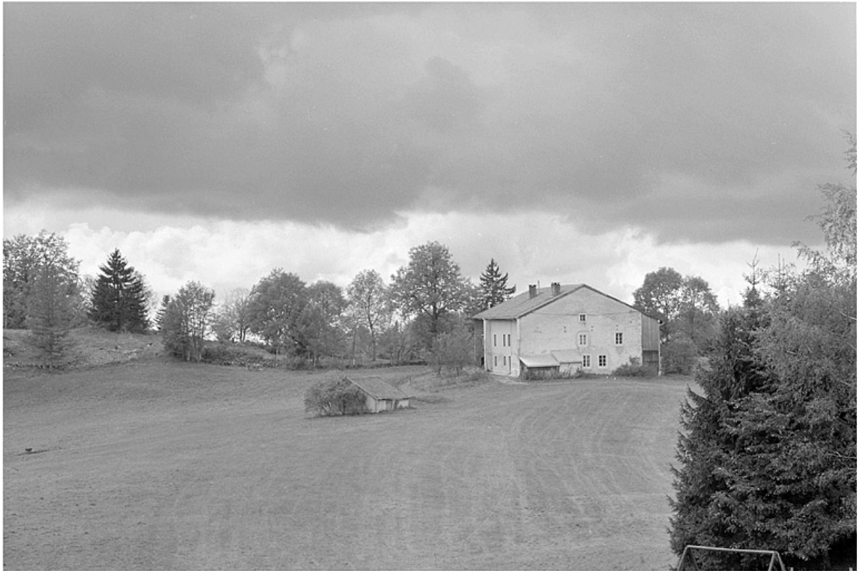
Vue générale depuis l'est.
