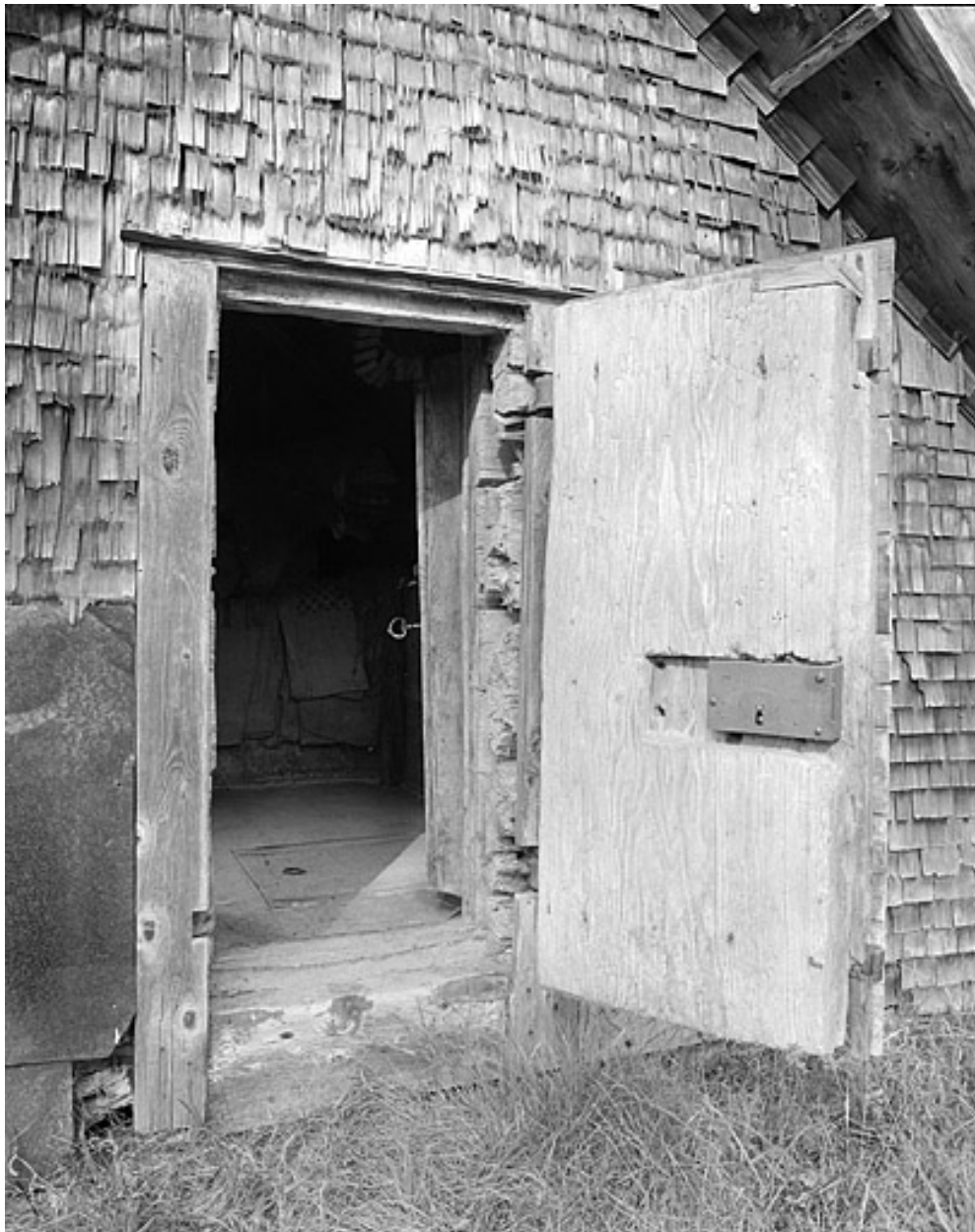
Les deux portes du grenier fort ouvertes.
