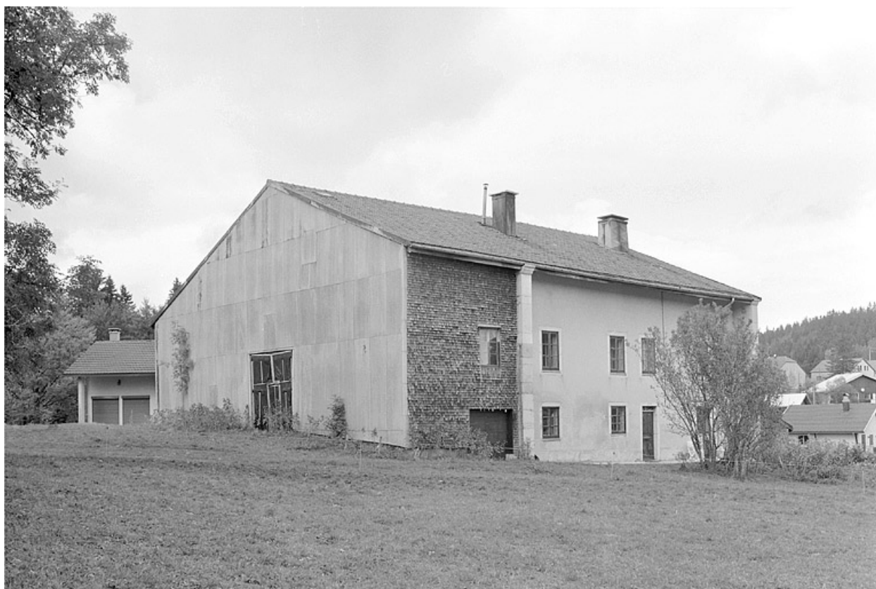
Façade antérieure et face sud-ouest.
