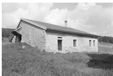
Façade antérieure. Phot. Jérôme Mongreville IVR43_19963901279X
