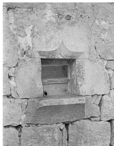
Fenêtre en accolade sur la façade postérieure. Phot. Jérôme Mongreville IVR43_19963901280X
