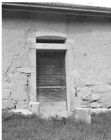
Porte du logis sur la façade antérieure. Phot. Jérôme Mongreville IVR43_19963901275X
