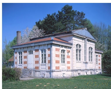
Façades ouest et sud. Phot. Jérôme Mongreville IVR43_20022500989VA
