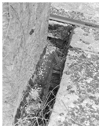
Pilier sud des mires nord de la lunette méridienne : espace entre le pilier et son puits. Phot. Jérôme Mongreville IVR43_20022501129X
