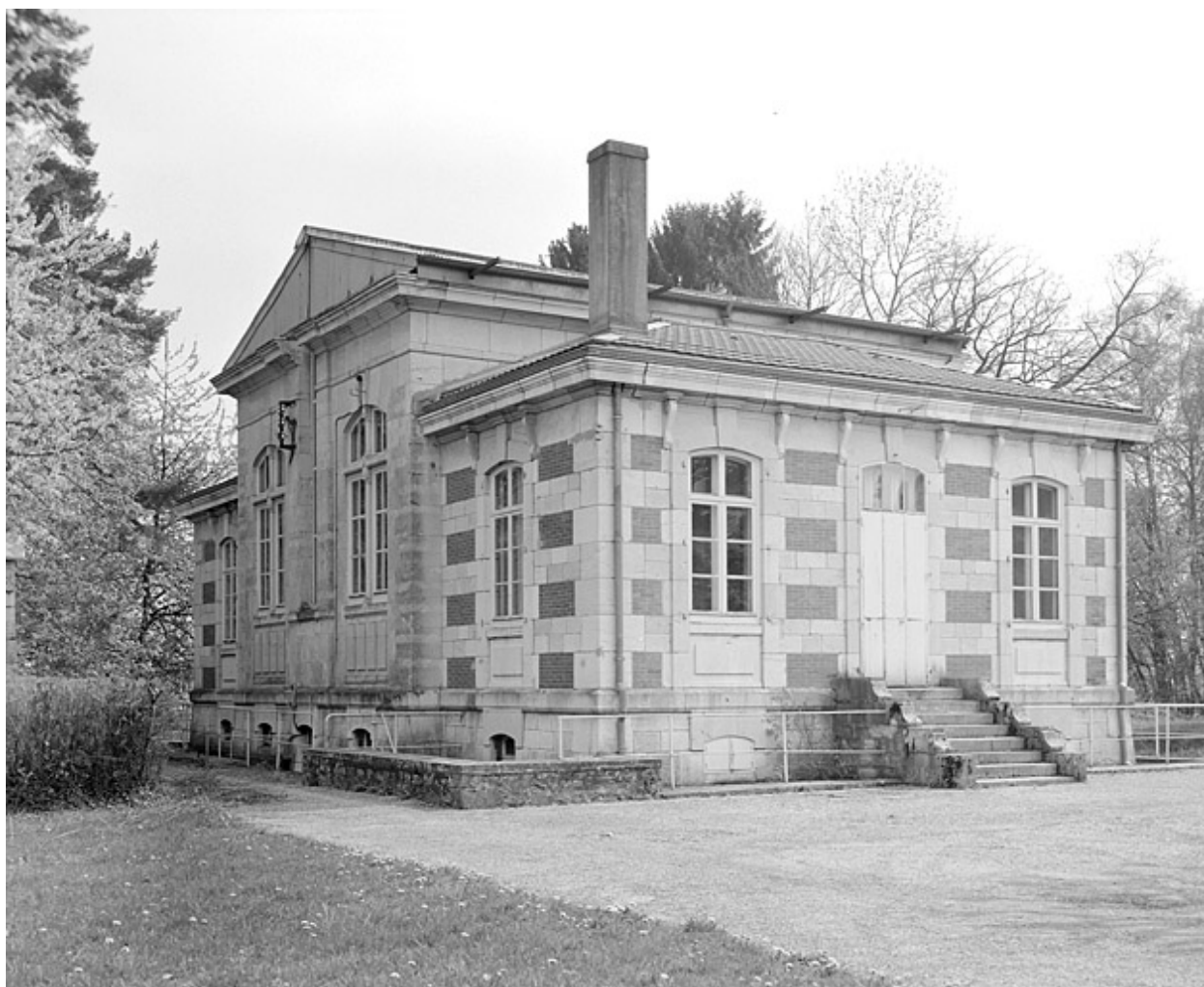
Façades nord et ouest.
