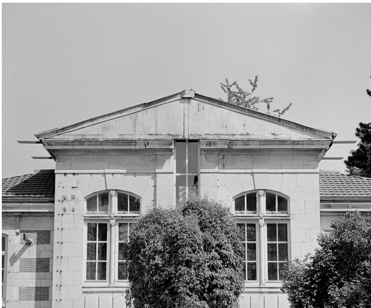
Toiture et fronton côté sud. De chaque côté dépassent les rails servant à l'écartement des versants du toit.
