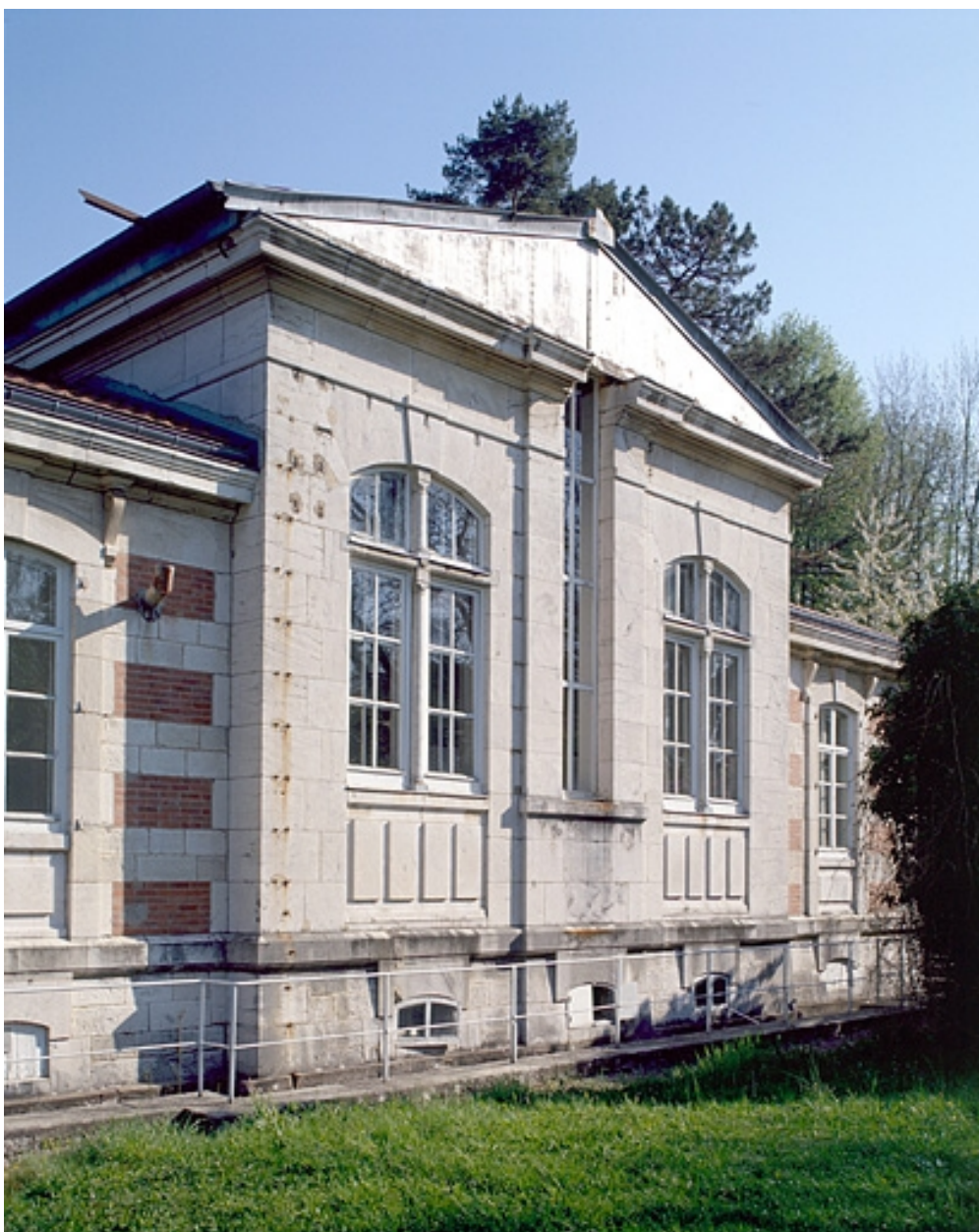
Façade sud, de trois quarts gauche.
