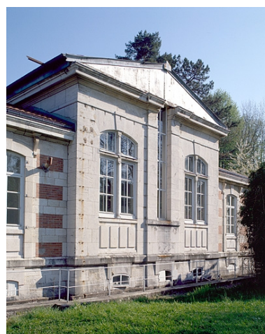
Façade sud, de trois quarts gauche.
