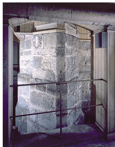
Sous-sol : pilier de la lunette méridienne et de sa pendule. Phot. Jérôme Mongreville
