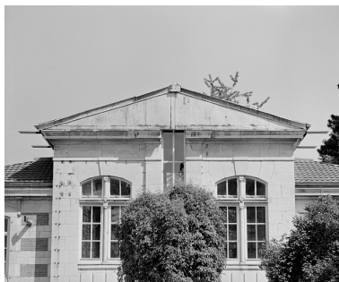
Toiture et fronton côté sud. De chaque côté dépassent les rails servant à l'écartement des versants du toit. Phot. Jérôme Mongreville IVR43_20042500091X
