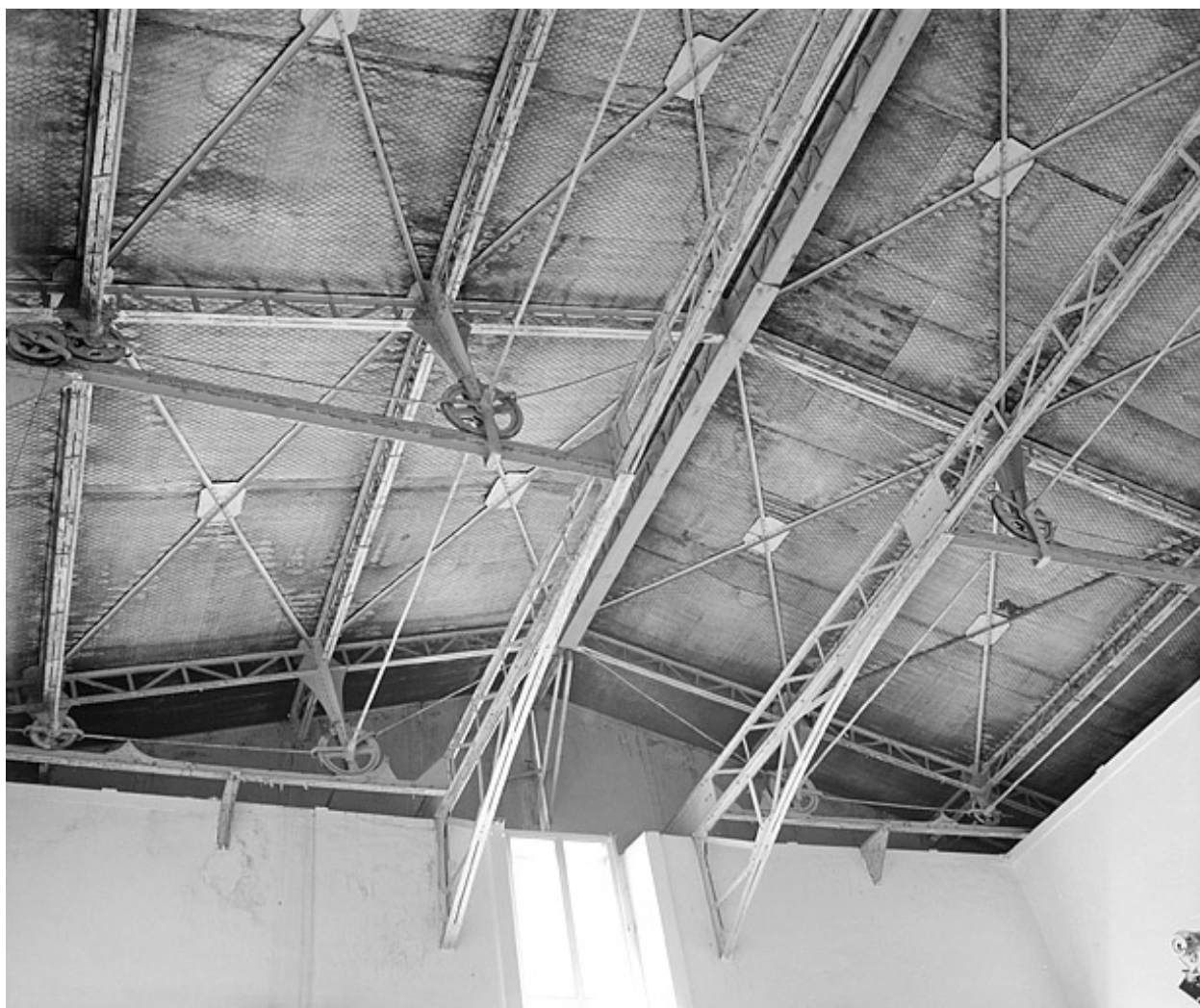
Charpente métallique de la toiture.
