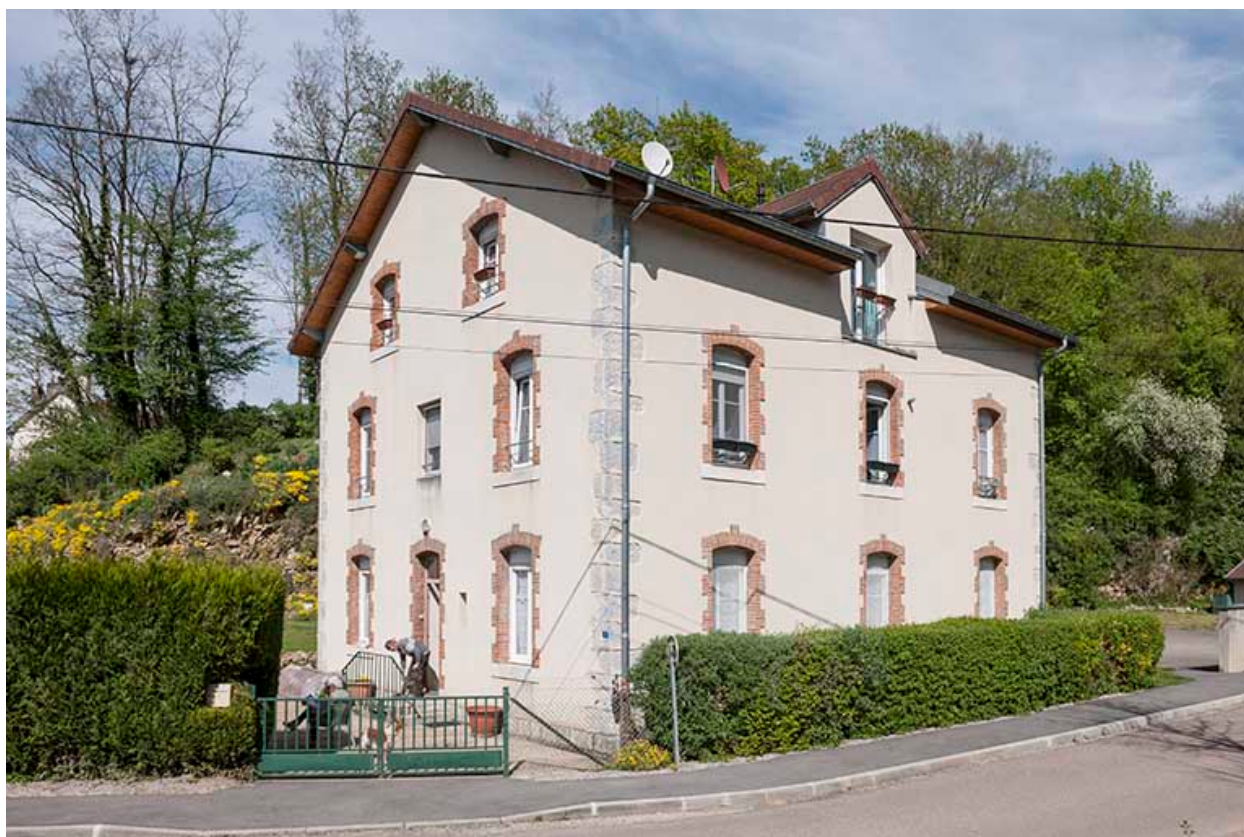
Logement (ou bureau ?) à l'entrée du site.
