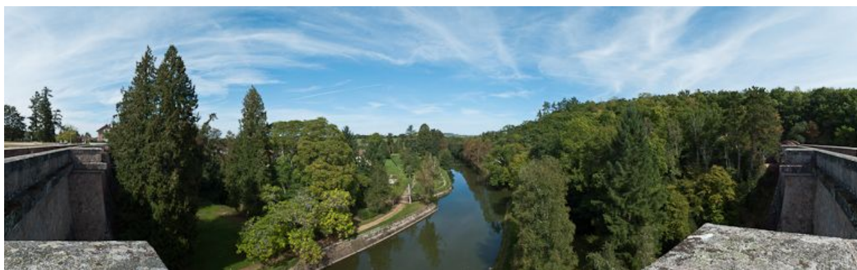
Vue générale de la rigole d'alimentation.
