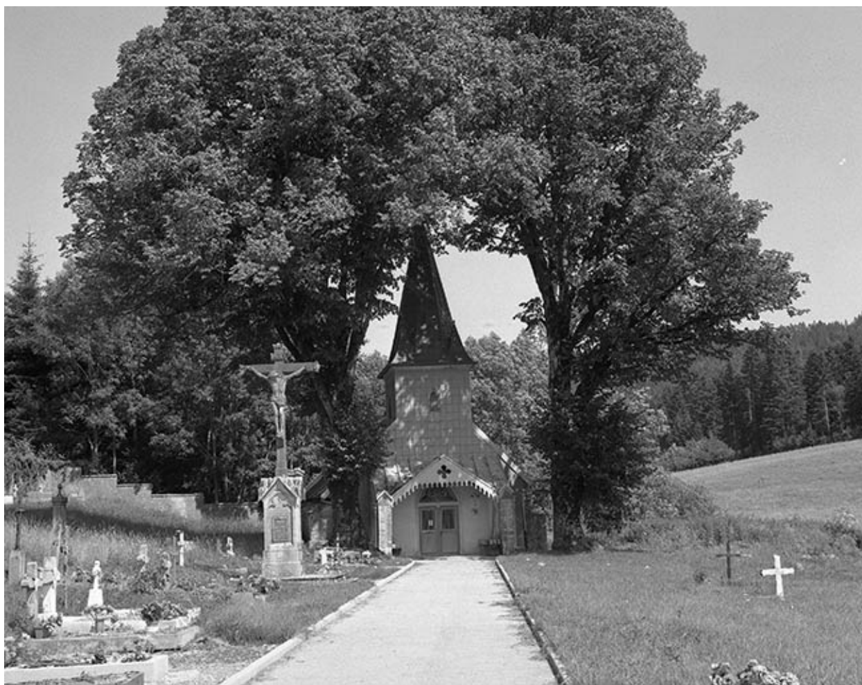
Façade antérieure et cimetière.
