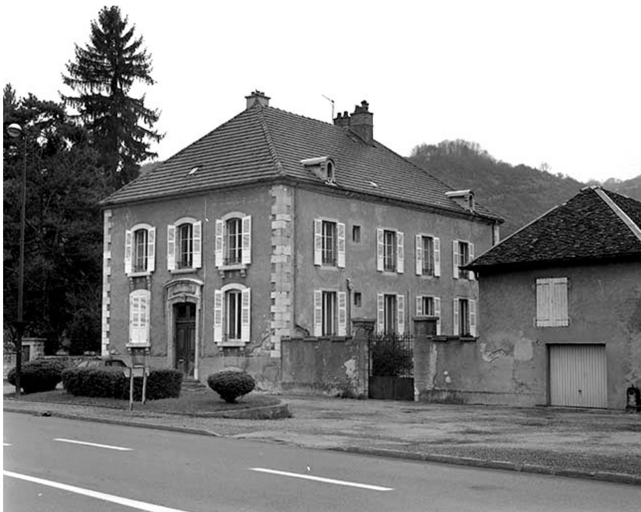
Vue de trois quarts depuis le sud-ouest (1997).
