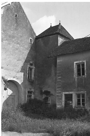
Le pigeonnier entre l'habitation et le bâtiment agricole. Phot. Bernard Lardière IVR43_19817000614Z
