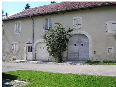
Vue de la façade antérieure. Phot. Marie-Pierre Reynet IVR43_20083900020NUC1A
