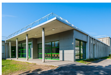
Bâtiment restauration. Phot. Jérôme Mongreville IVR43_20143900159NUC4A
