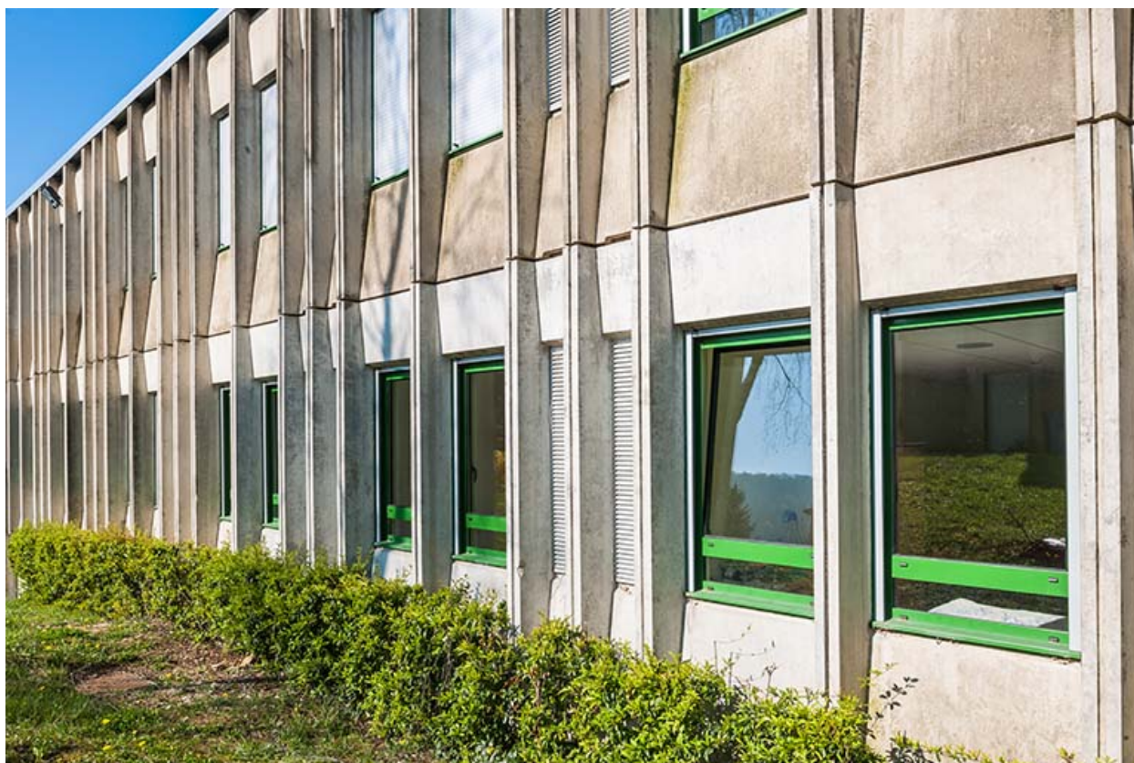
Façades préfabriquées : détail.
