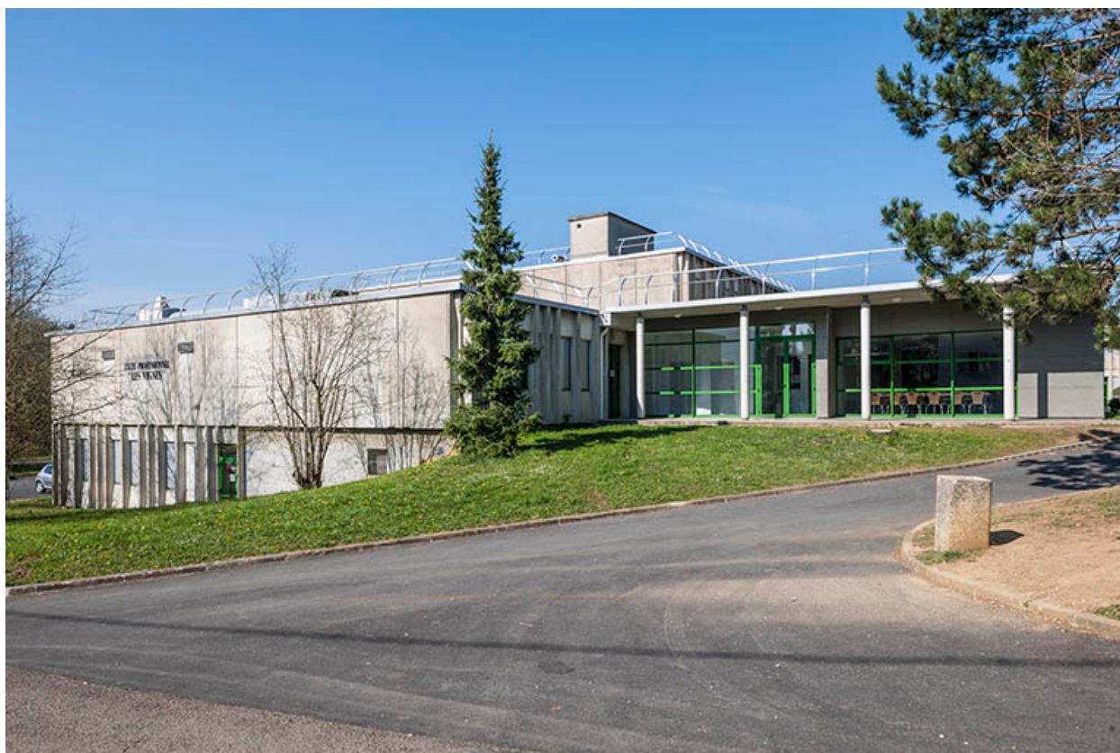
Bâtiment restauration : façade latérale.
