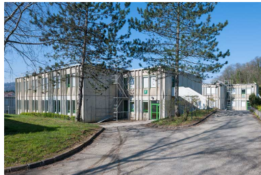
Entrée du lycée. Phot. Jérôme Mongreville IVR43_20143900152NUC4A
