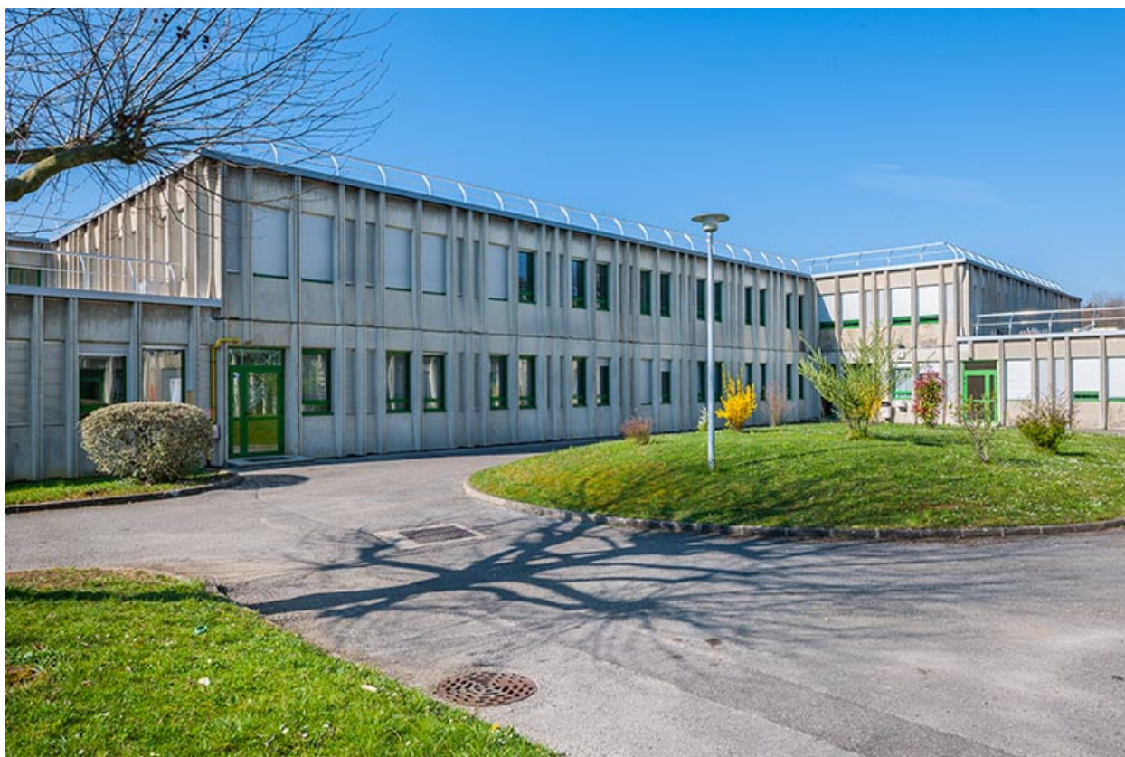
Infirmierie : façades postérieures
