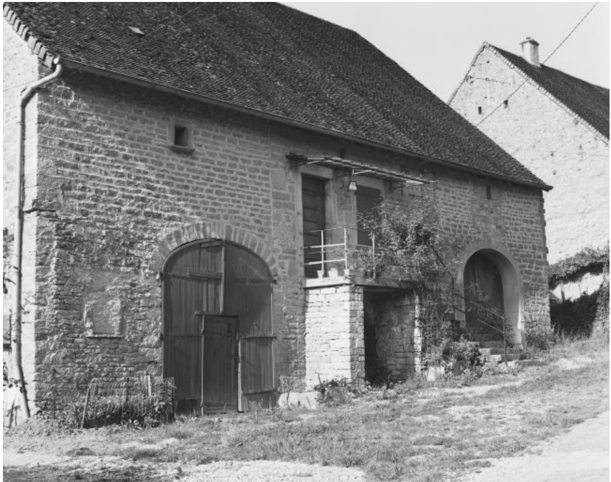
Ferme située rue du Bas du Village.
