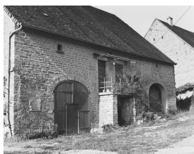
Ferme située rue du Bas du Village. Phot. Dominique Dominguez IVR43_19803900109X
