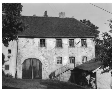
Ferme située rue du Petit Clos. Phot. Dominique Dominguez IVR43_19803900110X
