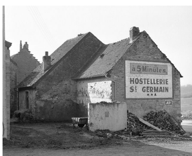
Ferme cadastrée 1959 AI 92 : façade postérieure (?). Phot. Yves Sancey IVR43_19753901061X
