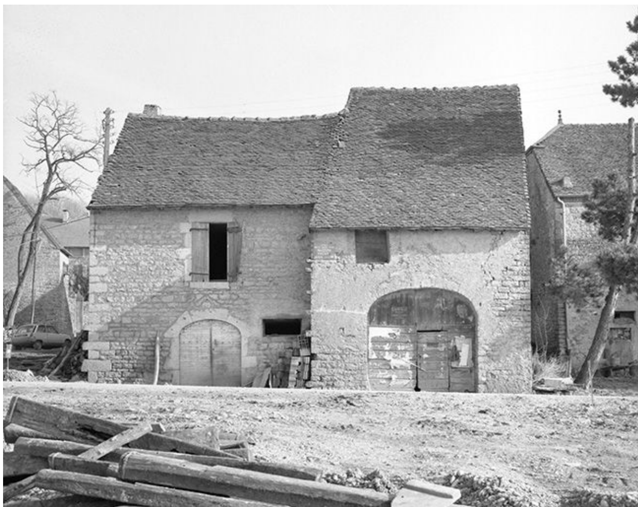
Ferme cadastrée 1959 AI 92 : façade antérieure.
