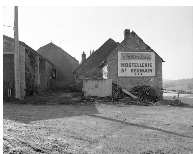
Ferme cadastrée 1959 AI 92 : façade postérieure (?). Phot. Yves Sancey IVR43_19753901060X
