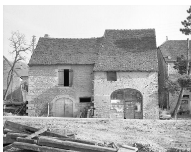
Ferme cadastrée 1959 AI 92 : façade antérieure. Phot. Yves Sancey IVR43_19753901057X
