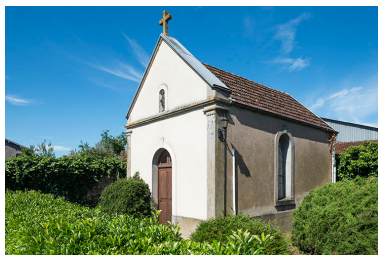
Vue générale de la chapelle.
