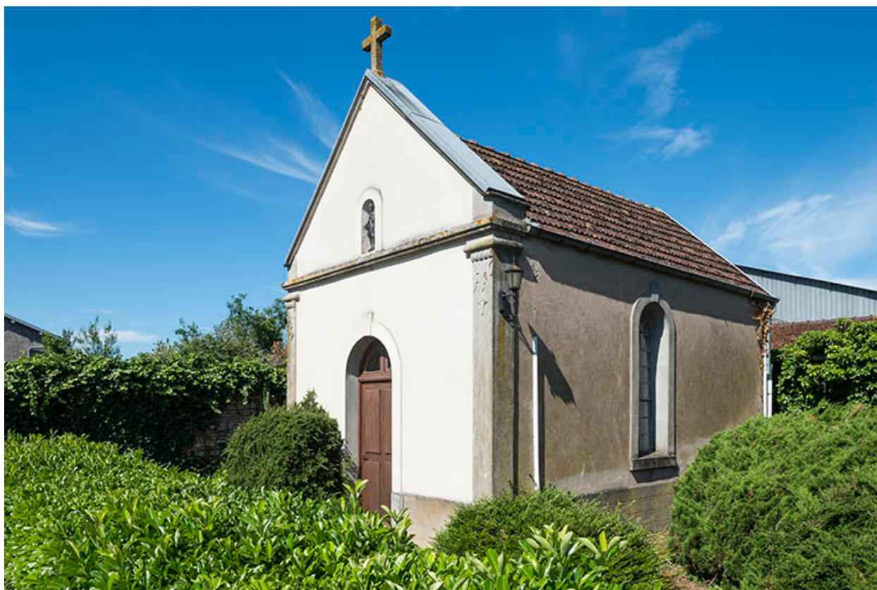
Vue générale de la chapelle.
