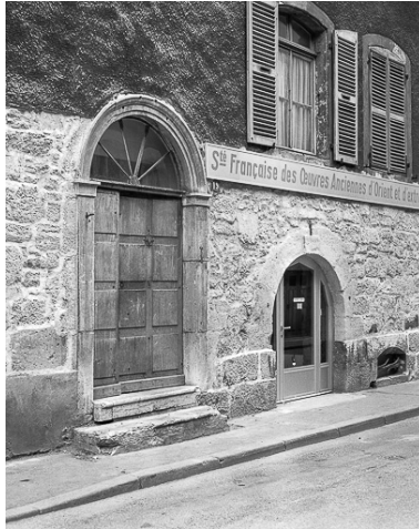
Détail : porte d'entrée. Phot. Yves Sancey IVR43_19802500274X
