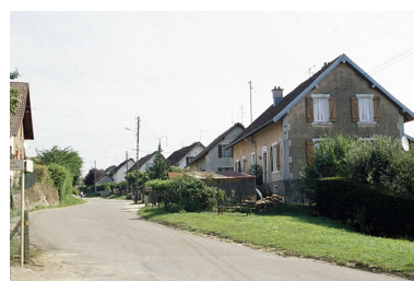
Logements ouvriers rue du Bois Lachat. Phot. Yves Sancey IVR43_20019000345ZA
