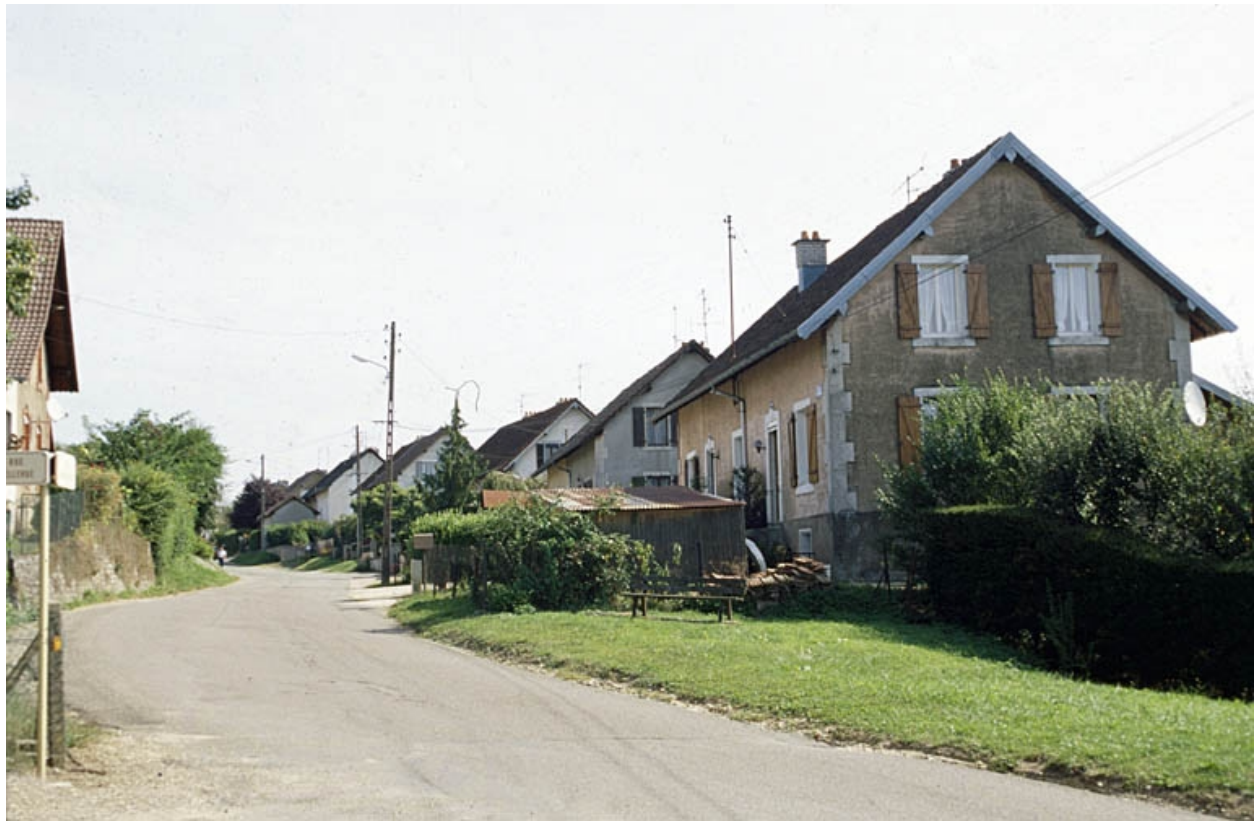
Logements ouvriers rue du Bois Lachat.
