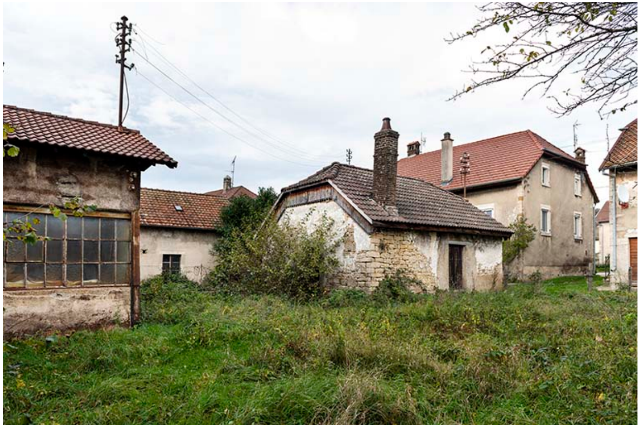
Forge : façades postérieure et latérale gauche.
