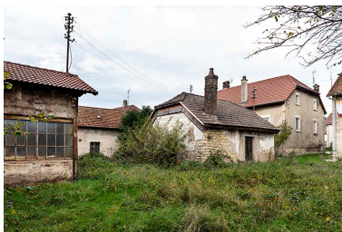
Forge : façades postérieure et latérale gauche.
