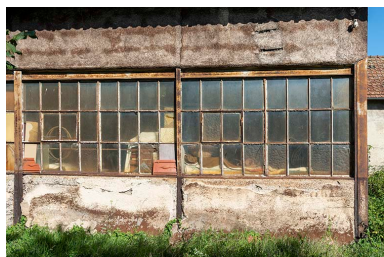
Polissage : baies d'atelier.
