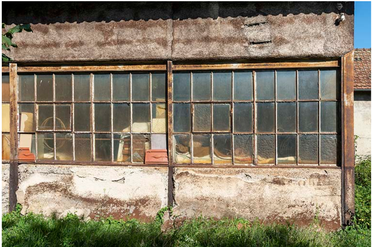
Polissage : baies d'atelier.
