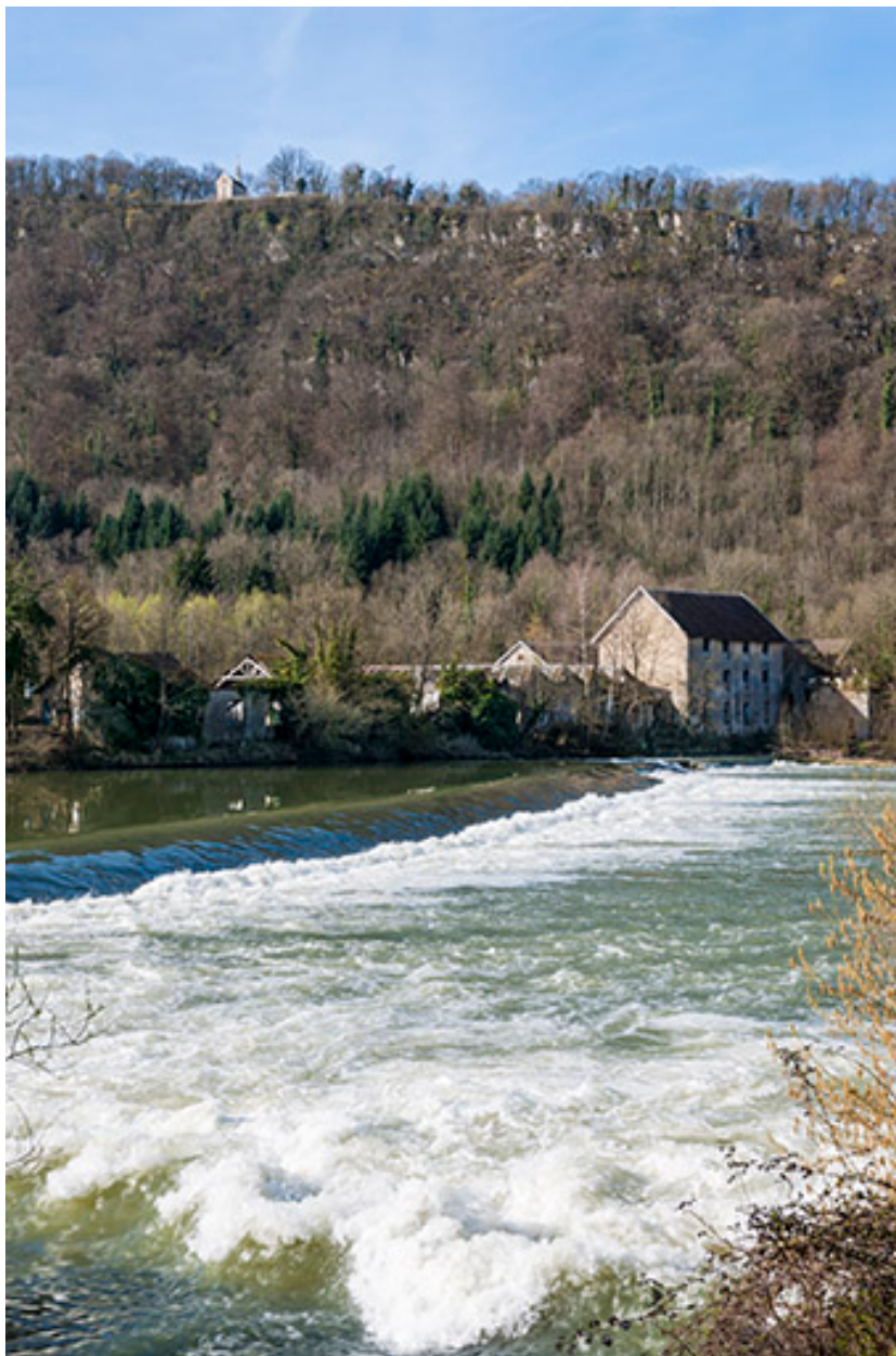
Vue d'ensemble depuis la rive droite.
