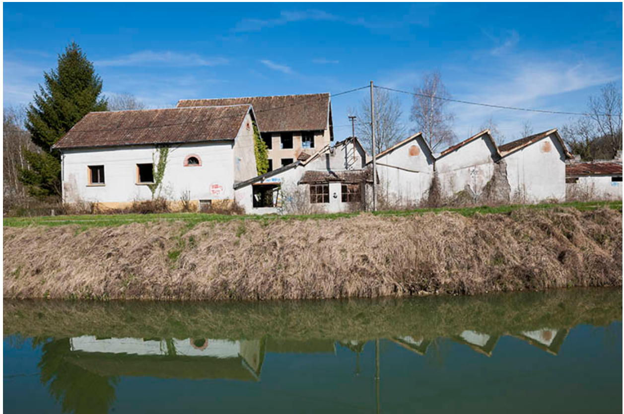
Façades sud de l'usine.
