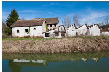
Façades sud de l'usine. Phot. Jérôme Mongreville IVR43_20152501177NUC4A
