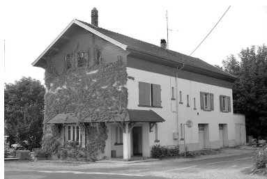
Logement, bureau, remise à automobile. Phot. Laurent Poupard IVR43_19923901316Z
