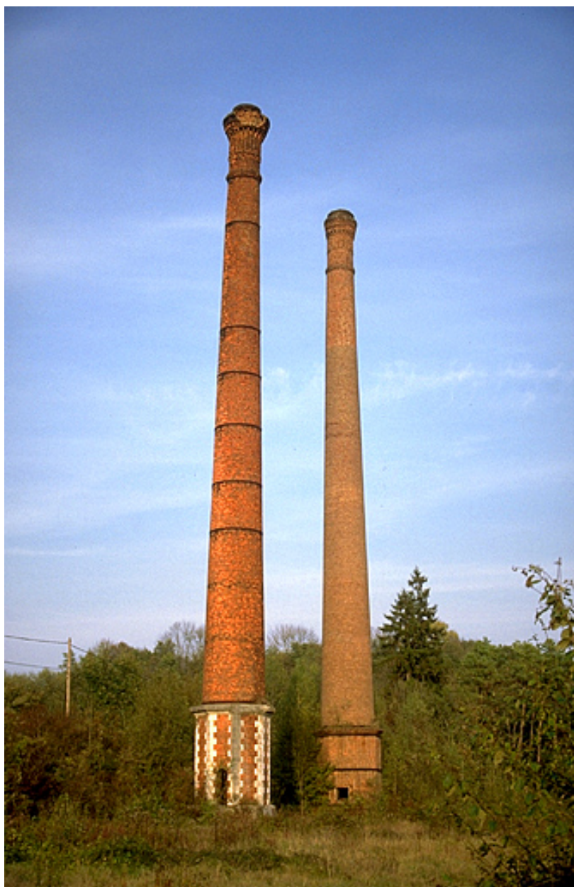
Cheminées d'usine, depuis le sud-ouest.
