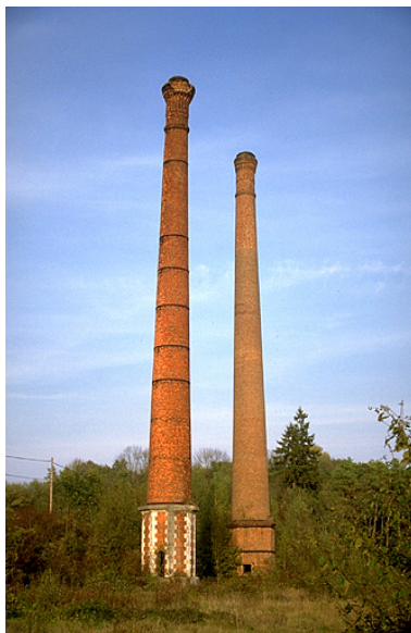
Cheminées d'usine, depuis le sud-ouest.
