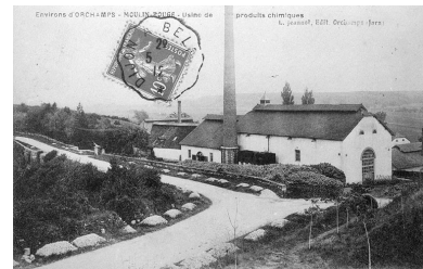
Environs d'Orchamps - Moulin- Rouge - Usine de produits chimiques. Phot. Laurent Poupard IVR43_19893901170Z
