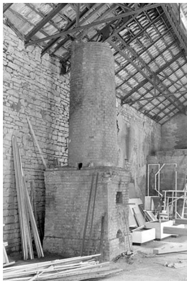
Atelier de réparation, intérieur : base de cheminée.
