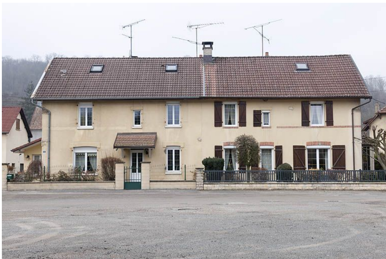
Immeuble à 4 logements. Façade est.
