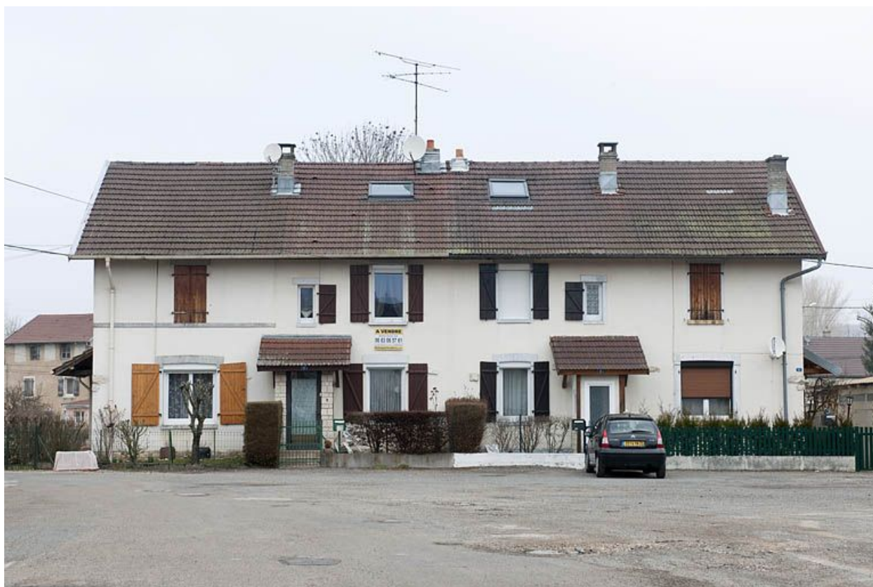
Immeuble à 4 logements. Façade sud.
