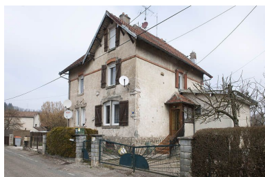
Maison à deux logements (de cadre ?). Phot. Jérôme Mongreville IVR43_20122500196NUC4A
