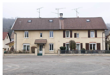
Immeuble à 4 logements. Façade est. Phot. Jérôme Mongreville IVR43_20122500195NUC4A
