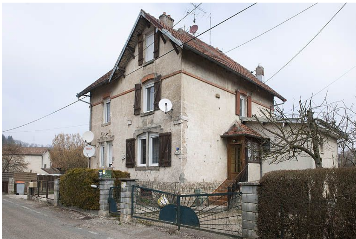
Maison à deux logements (de cadre ?).
