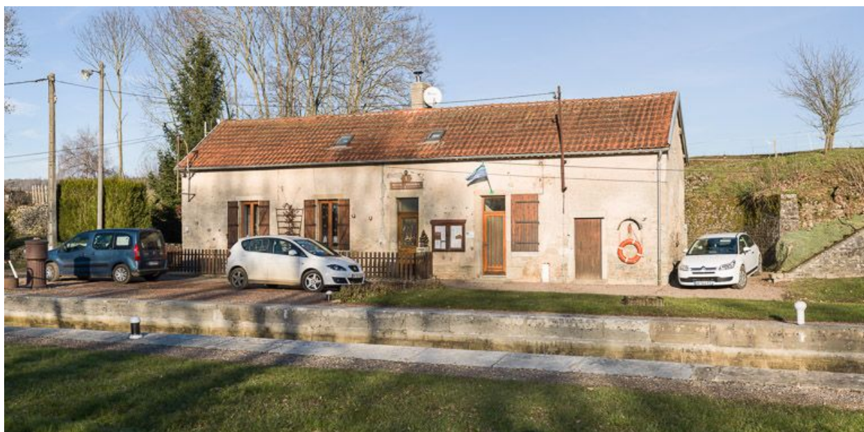
La maison éclusière vue de 3/4.
