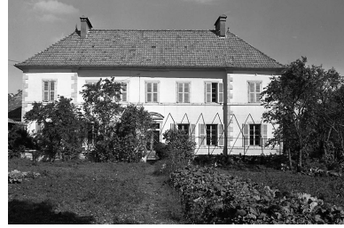
Presbytère. Phot. Yves Sancey IVR43_19802501072X
