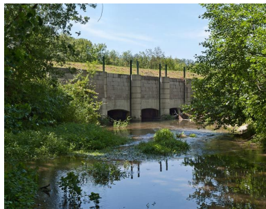
Vue de l'aqueduc. Phot. Pierre-Marie Barbe-Richaud IVR26_20118900326NUC4AQ
