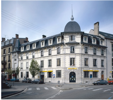
Façade antérieure. Phot. Yves Sancey IVR43_19883900096VA
