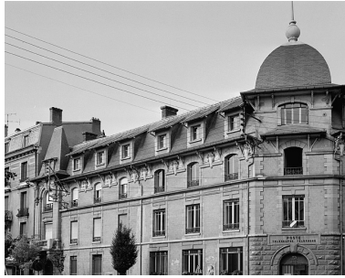
Détail de la façade antérieure. Phot. Yves Sancey IVR43_19833900362X
