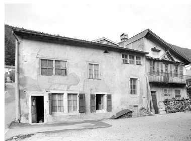
Elévations antérieures. Phot. Yves Sancey IVR43_20033900441X
