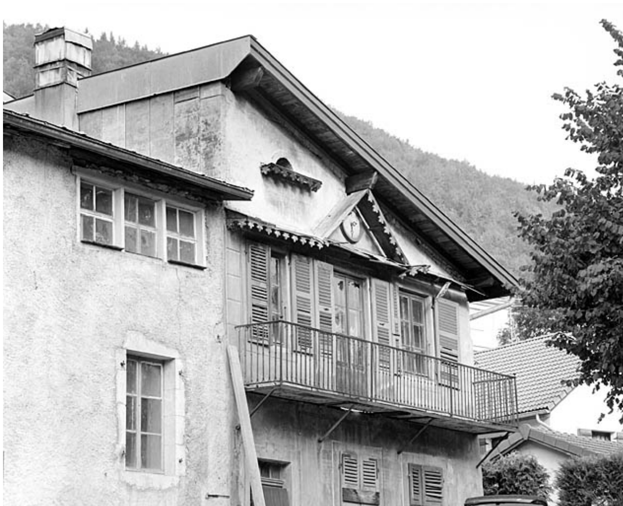
Etage du corps de bâtiment nord.
