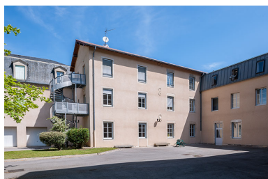
Façades postérieures des
