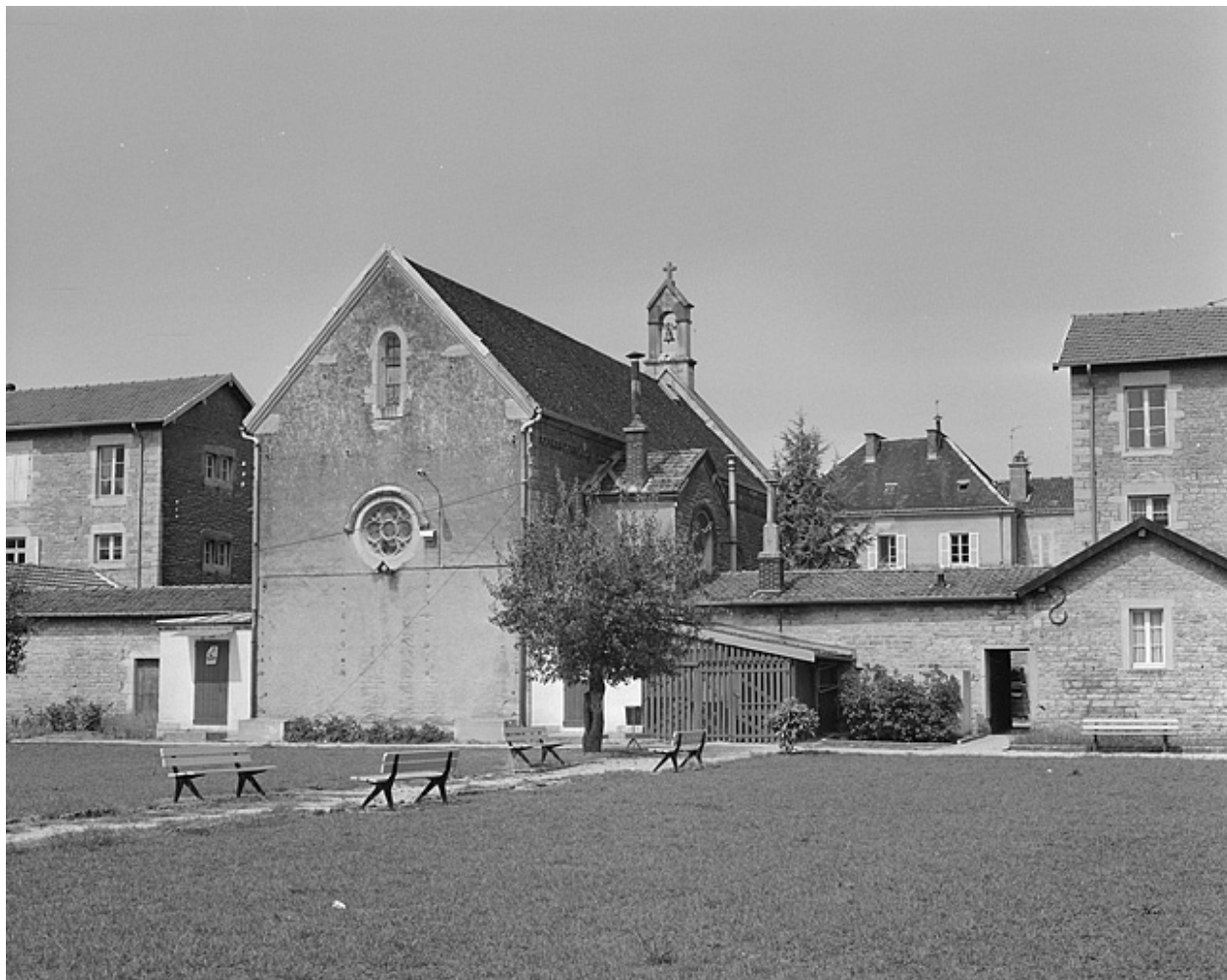
Chapelle, façade postérieure en 1983.
