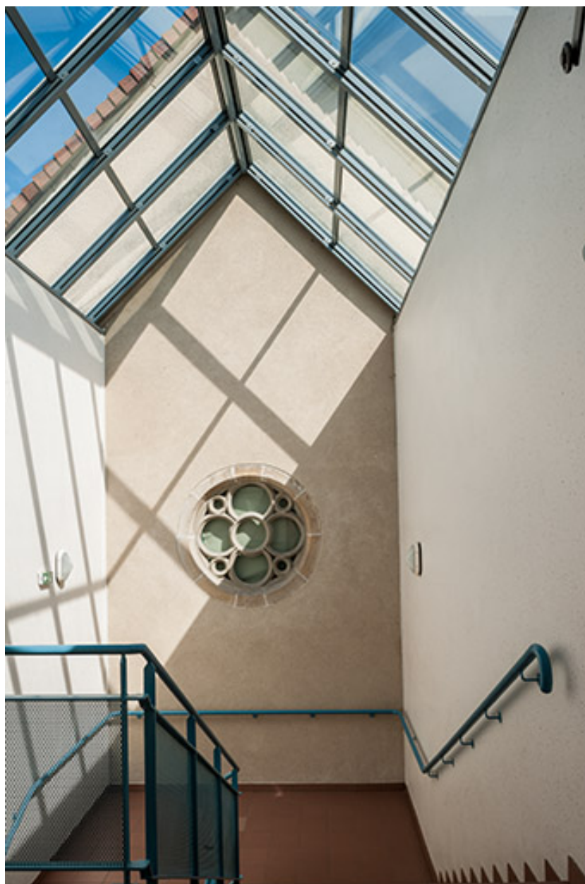
Chapelle : chevet, jonction avec l'extension sud
