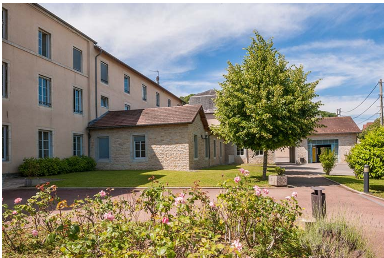
Façade postérieure de l'externat
