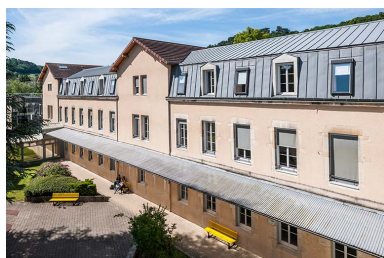
Façade Ouest sur cour de l'externat
