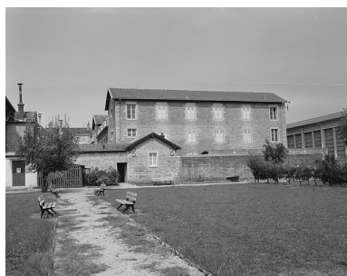
Façade latérale d'un des pavillons en 1983. Phot. Yves Sancey IVR43_19833900135X
