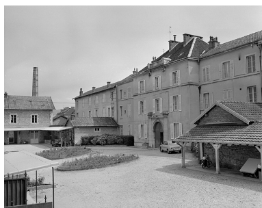
Façade principale sur l'avenue de Montciel en 1983. Phot. Yves Sancey IVR43_19833900134X
