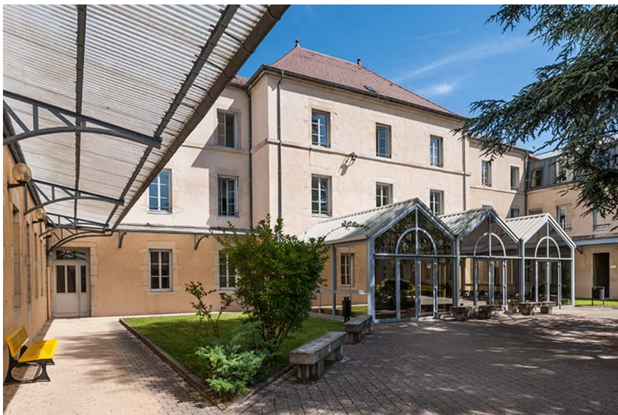
Façade postérieure du pavillon d'entrée
