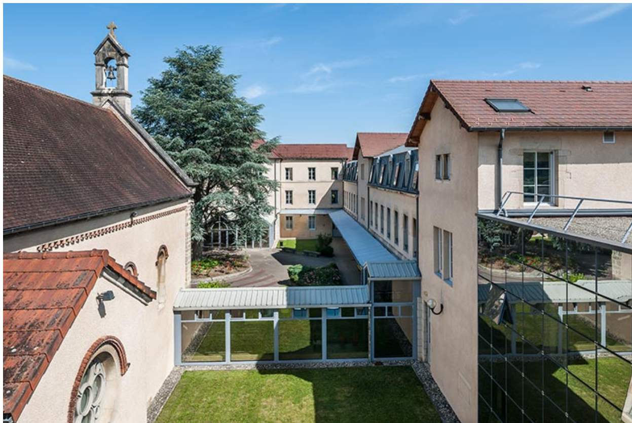
Façades Est sur cour : externat, chapelle.
