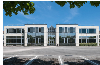
Façades extension Sud : externat Phot. Jérôme Mongreville IVR43_20143900359NUC4A
