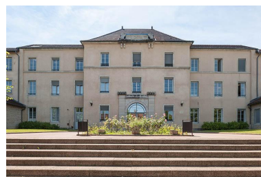
Façade du lycée depuis l'avenue Montciel Phot. Jérôme Mongreville IVR43_20143900343NUCA
