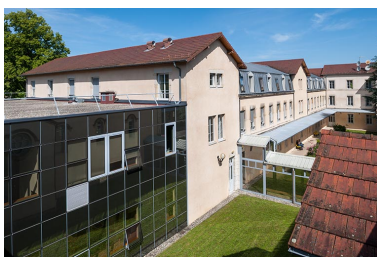
Façades Ouest sur cours : cafétéria,
