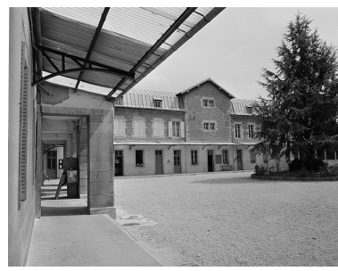
Cour intérieure, vue depuis le pavillon d'entrée en 1983. Phot. Yves Sancey IVR43_19833900137X
