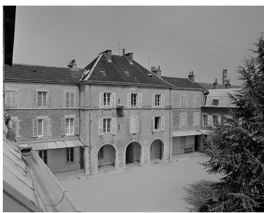
Pavillon d'entrée, vue de la cour intérieure en 1983. Phot. Yves Sancey IVR43_19833900136X
