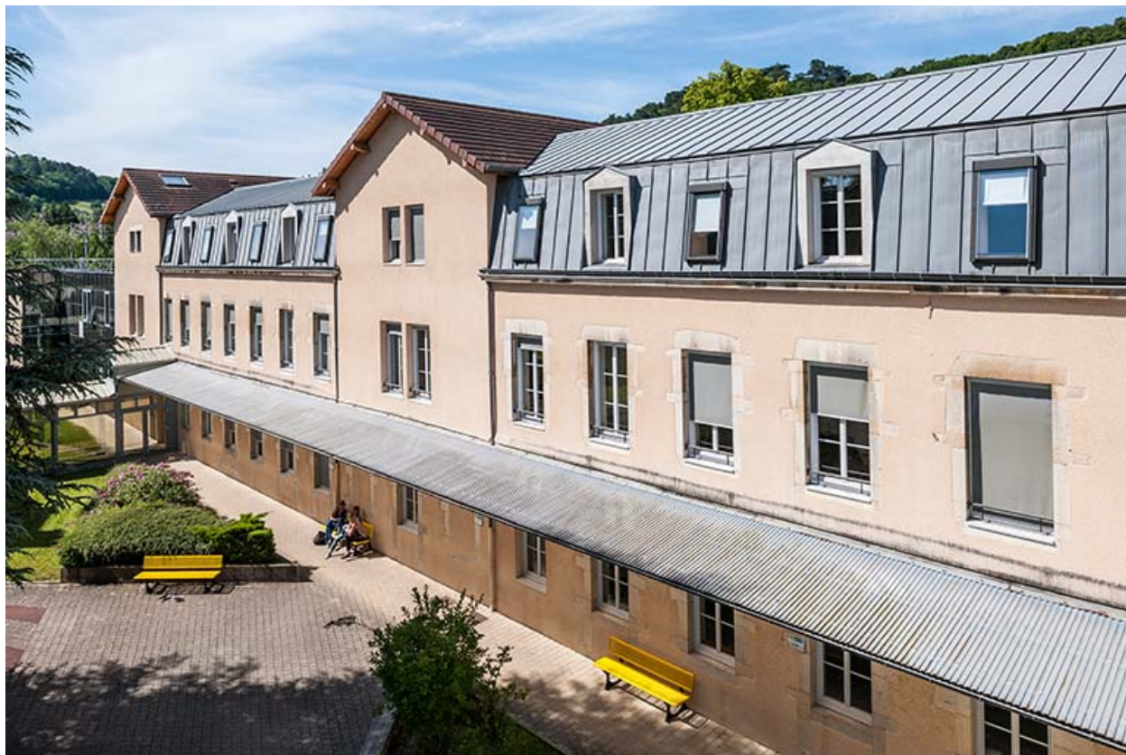
Façade Ouest sur cour de l'externat
