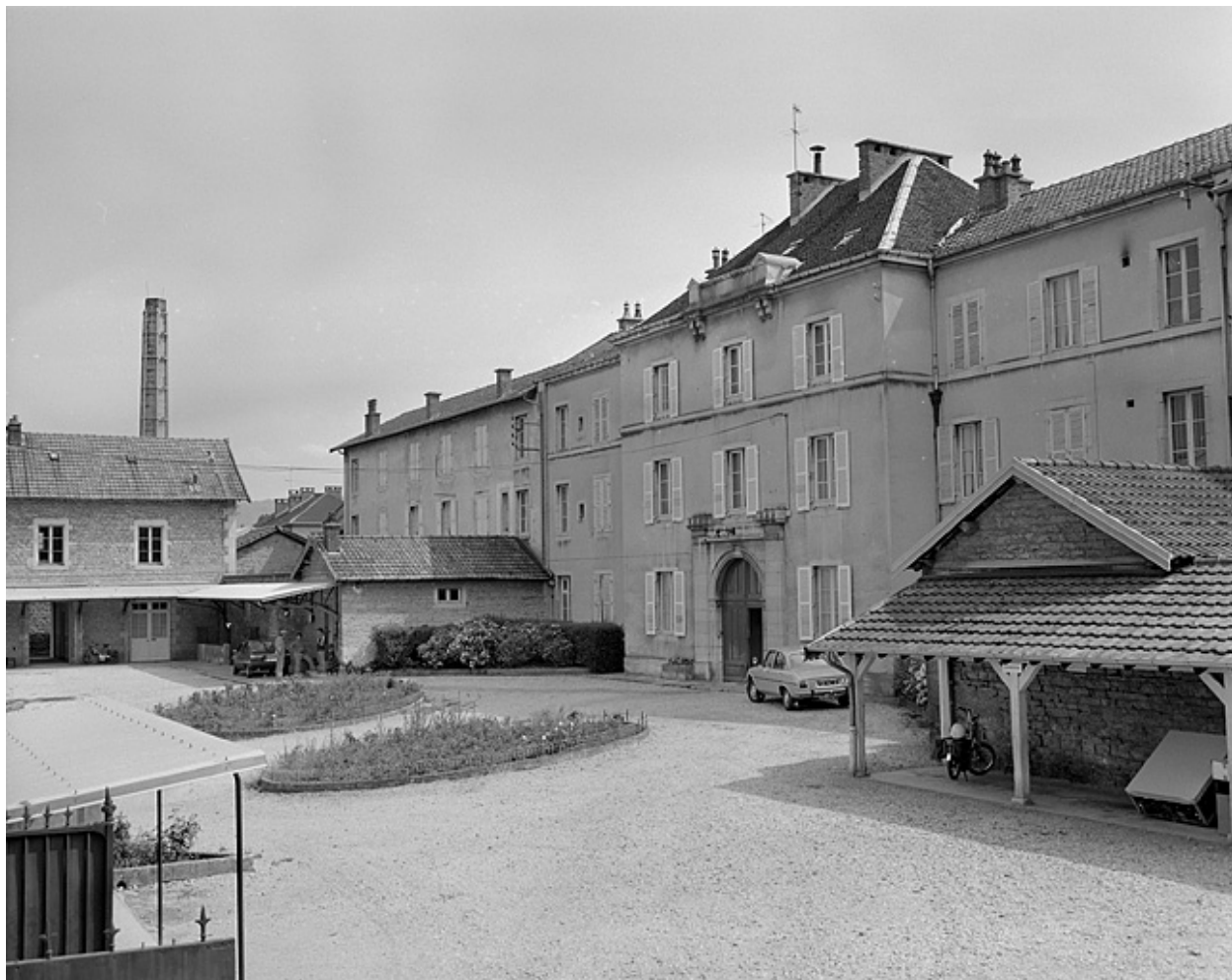
Façade principale sur l'avenue de Montciel en1983.
