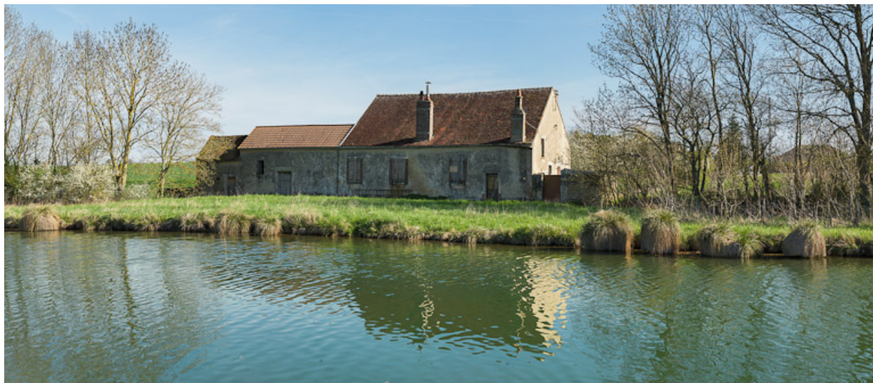
Les petits bâtiments en aval du port.
