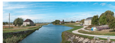
Vue d'ensemble avec de part et d'autre les deux constructions. Phot. Pierre-Marie Barbe-Richaud IVR21_20121000255NUC4AQ
