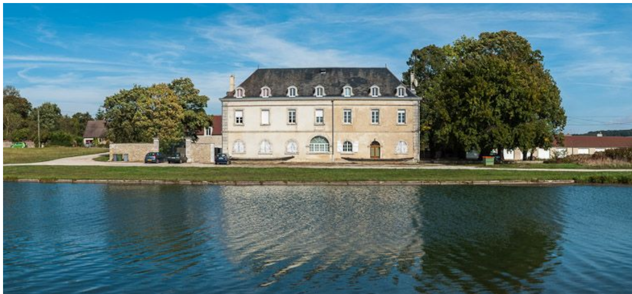
Le bâtiment à couverture d'ardoise vu de face.
