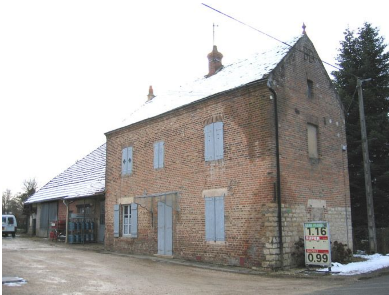
Exemple d'une maison à Authumes.
