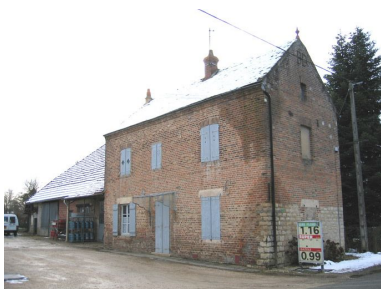
Exemple d'une maison à Authumes.
