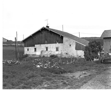
Ferme à Villedieu-les- Rochejean : façade latérale gauche. Phot. Yves Sancey IVR43_19782500395X
