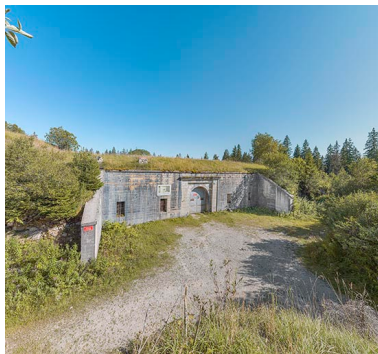
Bâtiment d'entrée, vue de trois quarts gauche. Phot. Thierry Kuntz IVR43_20243901243NUC4A
