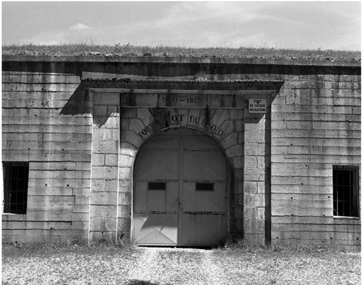
Entrée du fort (en 2001).
