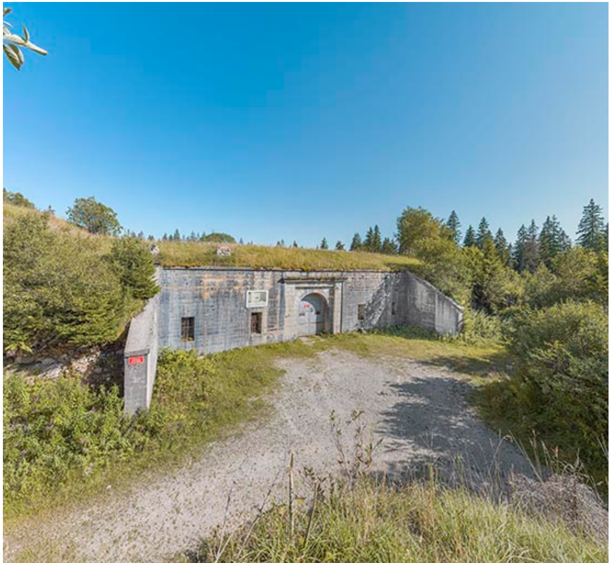
Bâtiment d'entrée, vue de trois quarts gauche.
