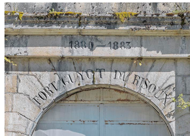
Date portée et nom du fort. Phot. Thierry Kuntz IVR43_20243901245NUC4A
