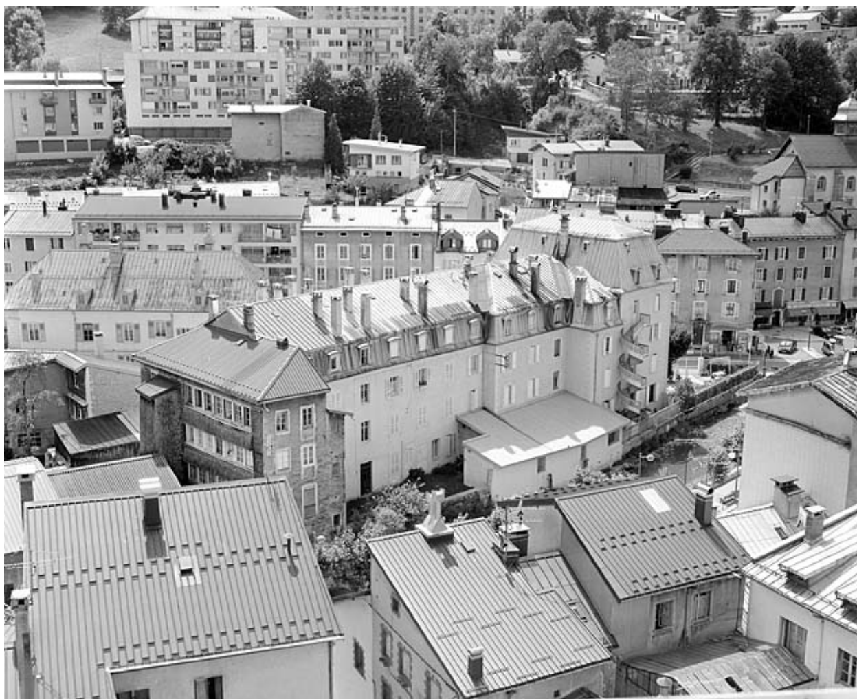
Vue d'ensemble plongeante, depuis l'est.
