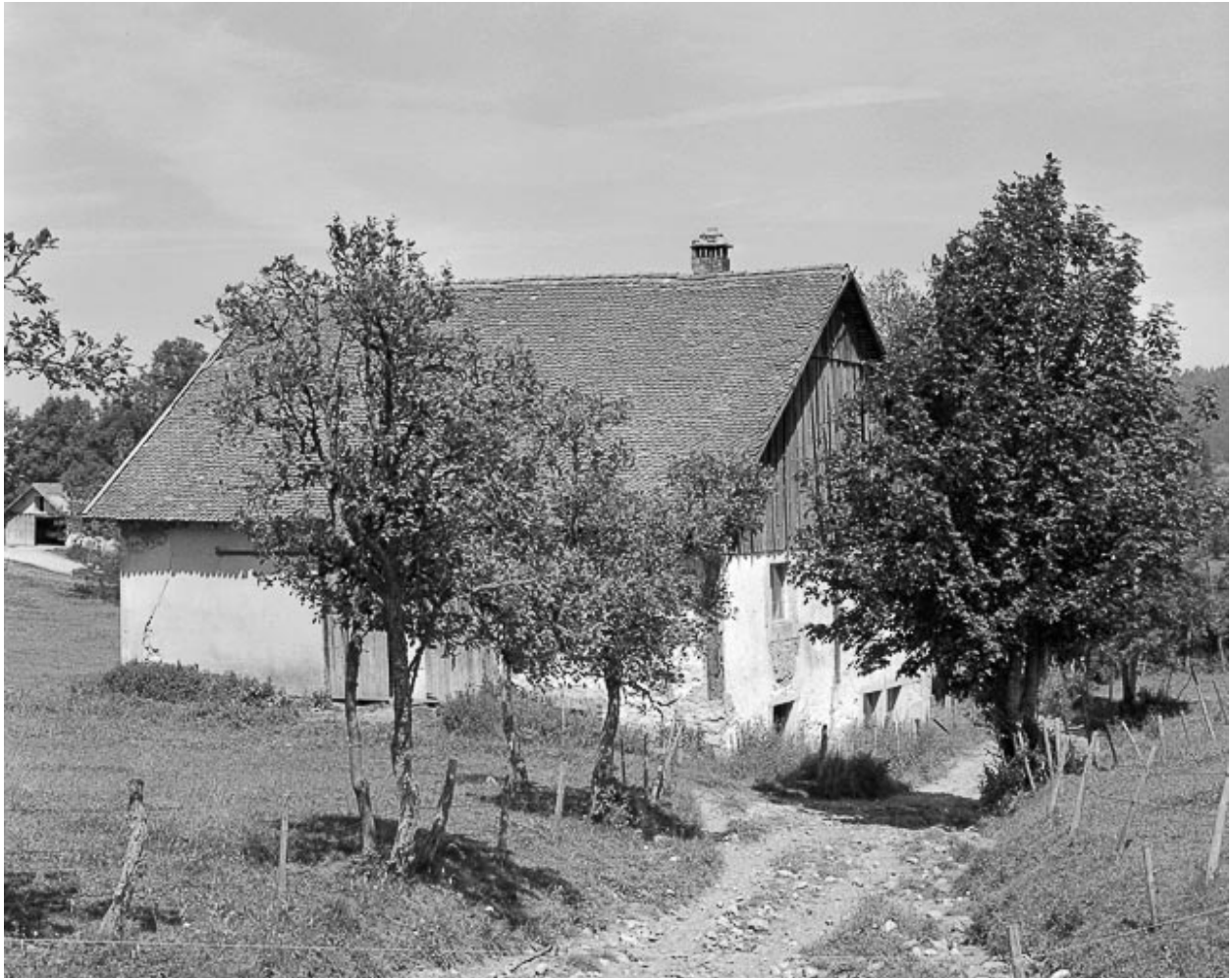
Façade antérieure et latérale gauche.
