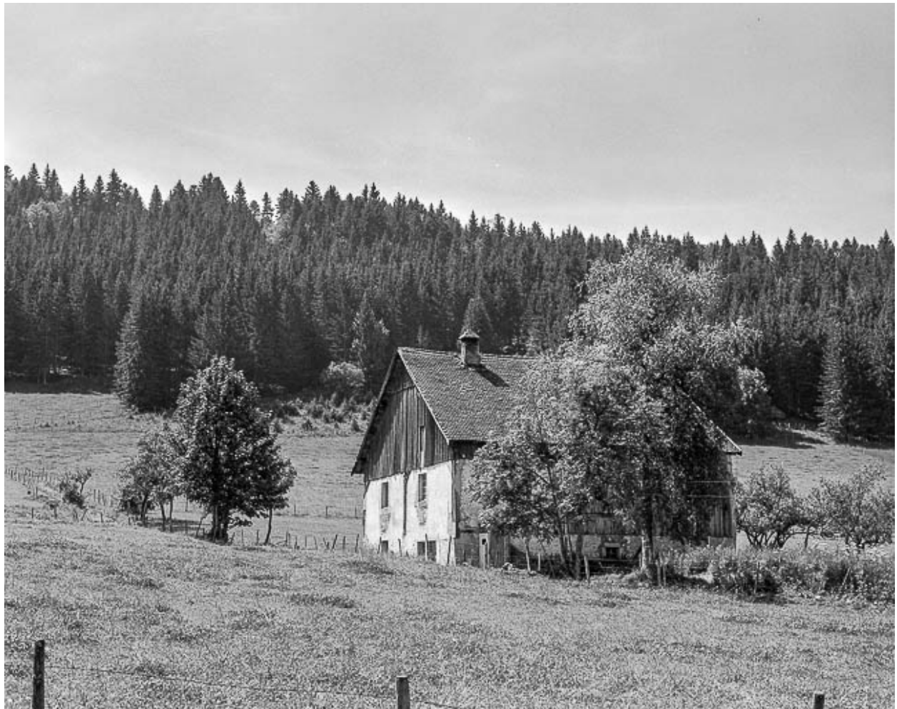
Façade latérale droite.
