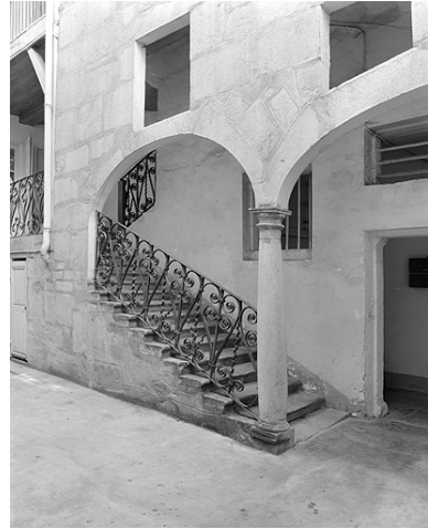
Départ de l'escalier s'ouvrant sur la cour. Phot. Yves Sancey IVR43_19833900568X
