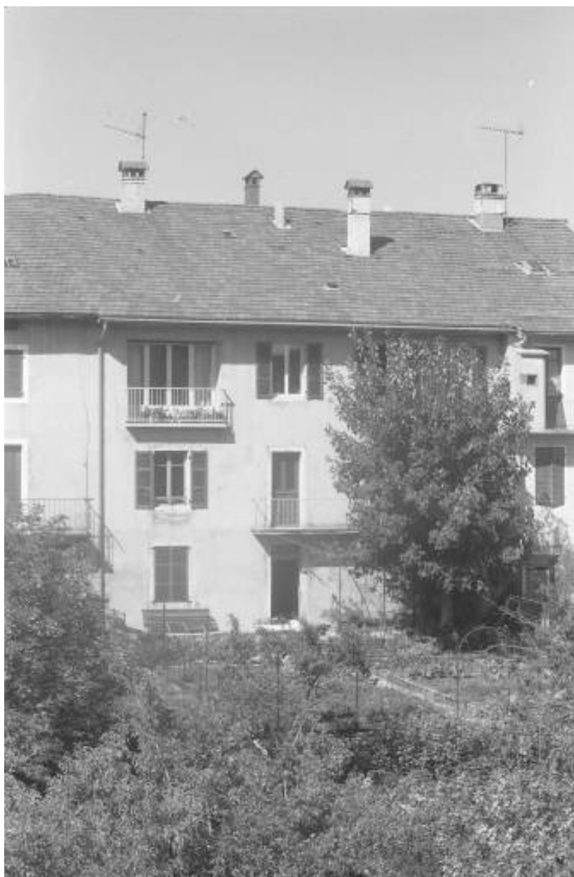
Vue rapprochée de la façade postérieure.
