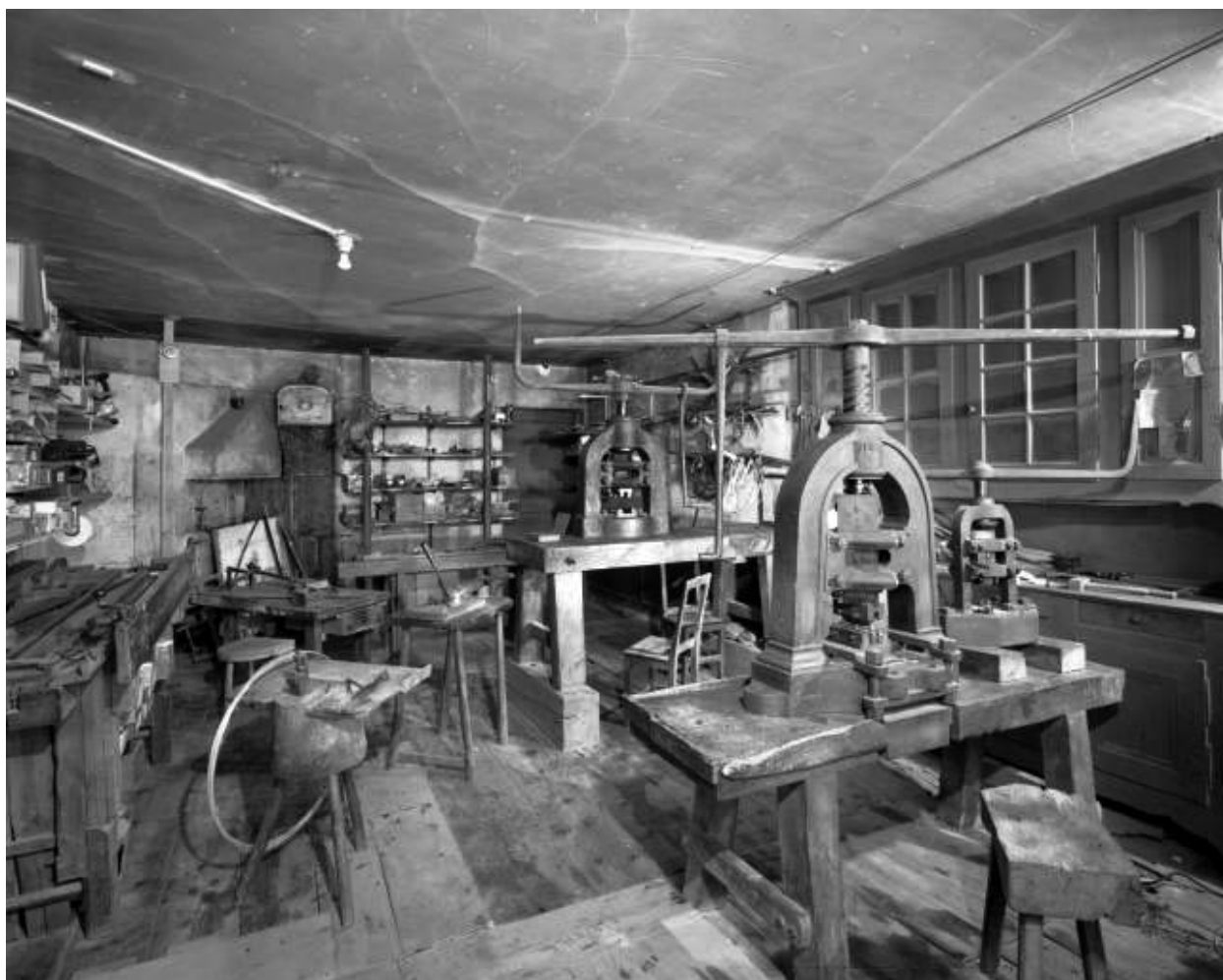
Intérieur de l'atelier de fabrication.
