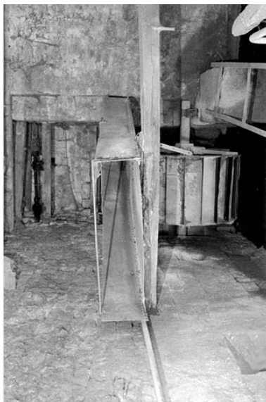
Roue en dessus et conduite d'amenée. Phot. Laurent Poupard IVR43_19923901178Z
