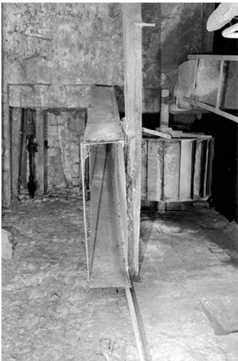
Roue en dessus et conduite d'amenée.
