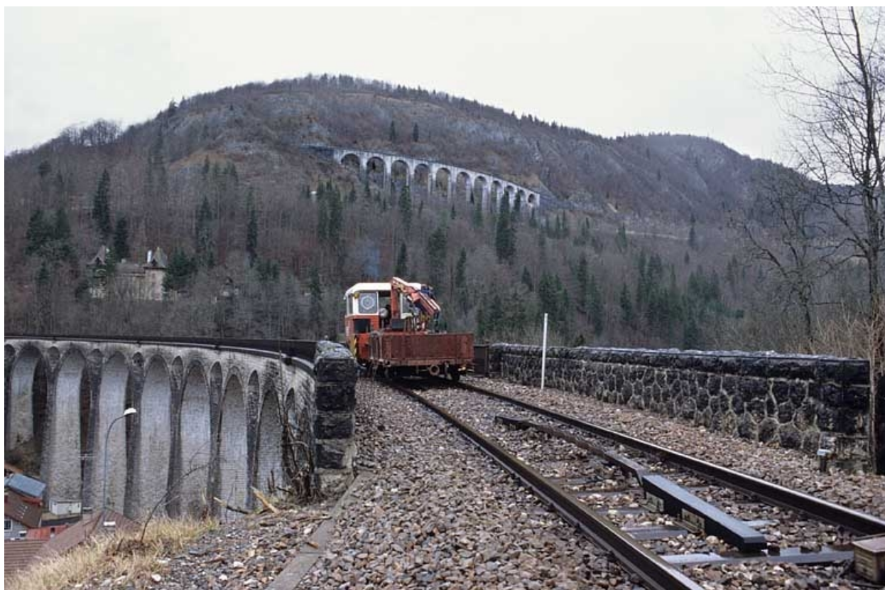
Draisine sur le viaduc de Morez.
