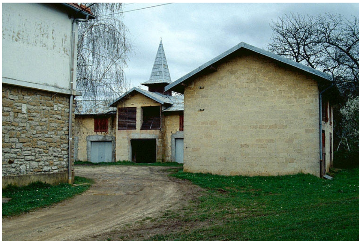
Remise d'automobile et bûcher (F) : entrée.
