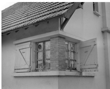
Maison (B) : fenêtres d'angle. Phot. Yves Sancey IVR43_19943901620X
