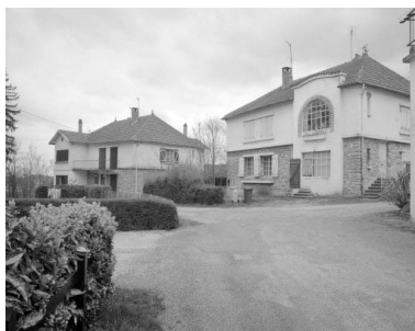
Maisons (G, D) : vue d'ensemble.
