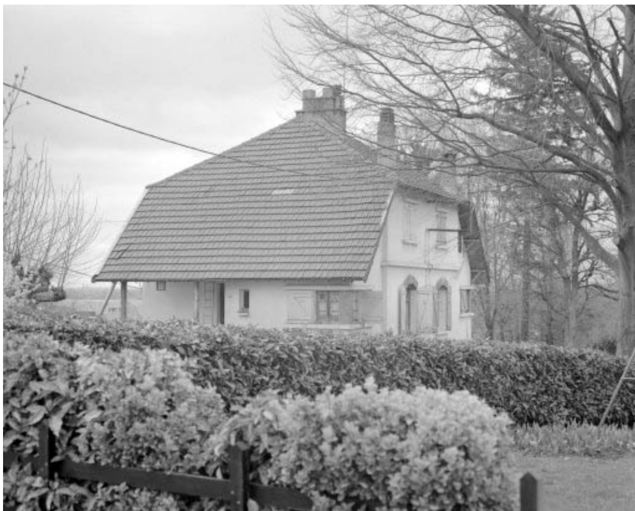
Maison (B) : façades postérieure et latérale droite.
