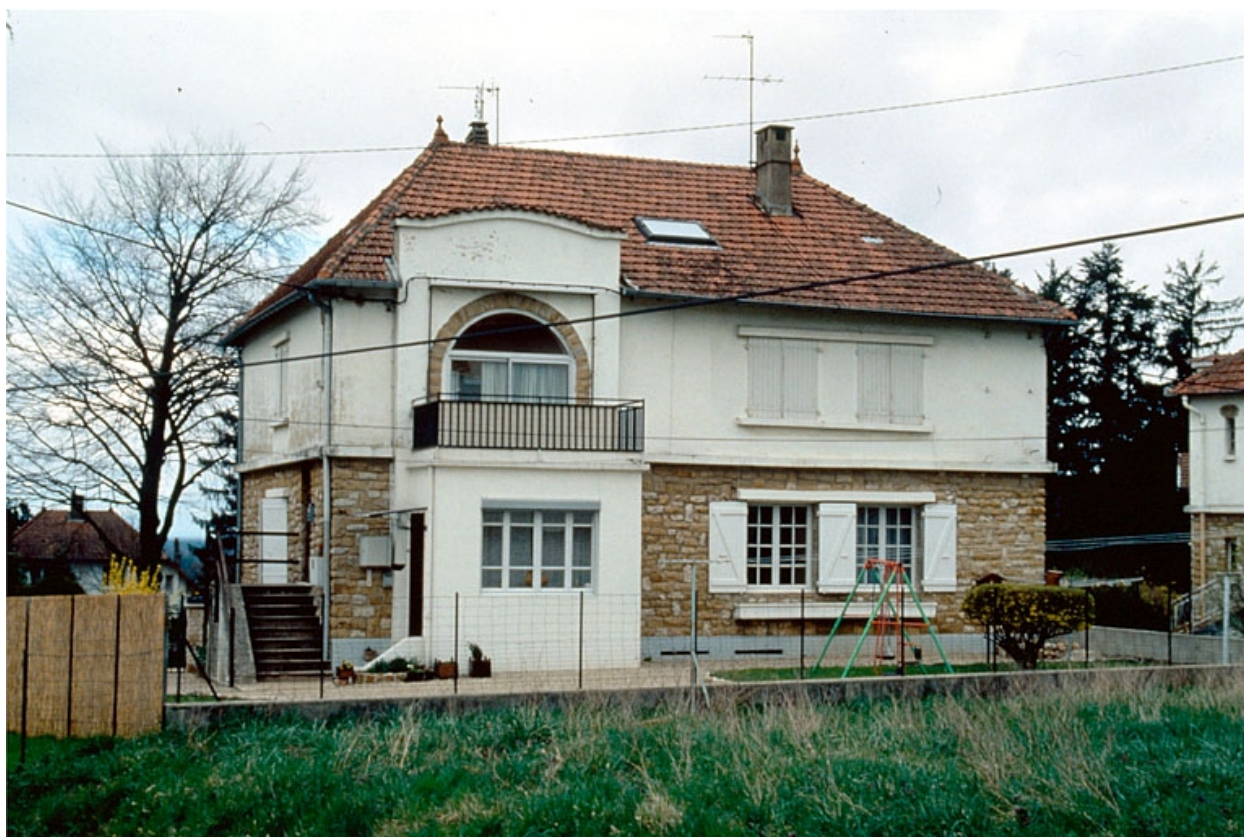
Maison (H) : façade postérieure.
