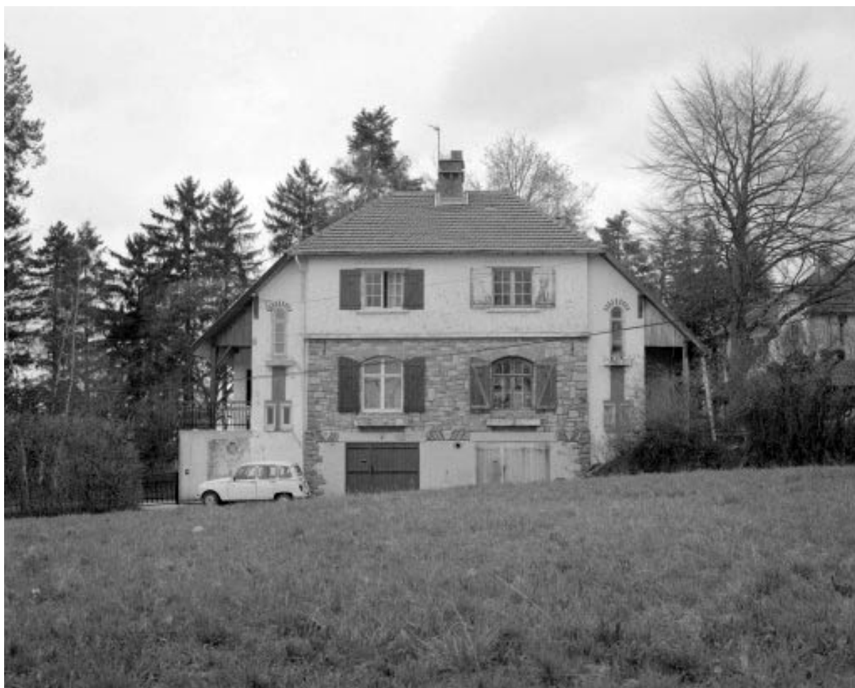
Maison (B) : façade antérieure.
