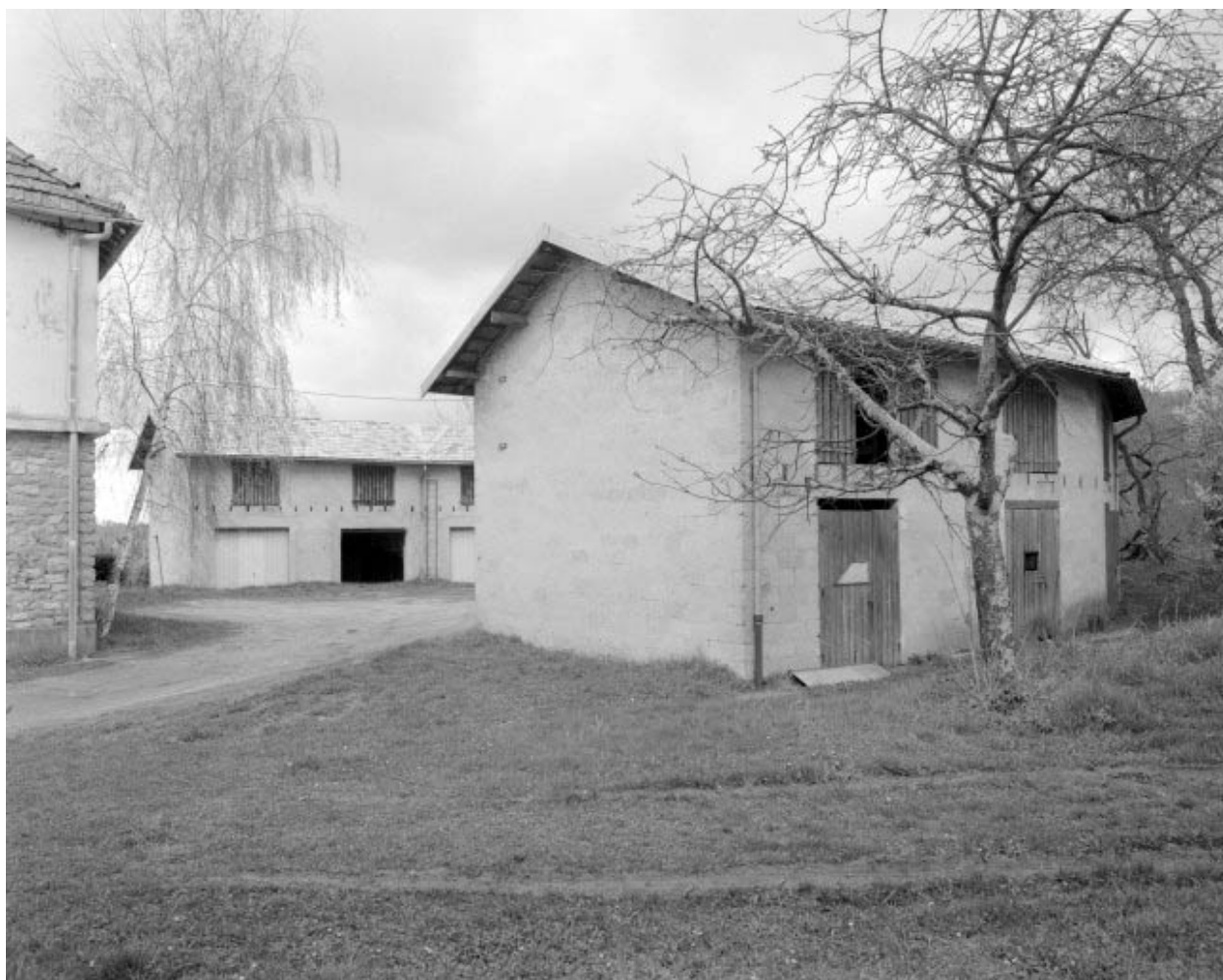
Remise d'automobile et bûcher (F) : vue d'ensemble.
