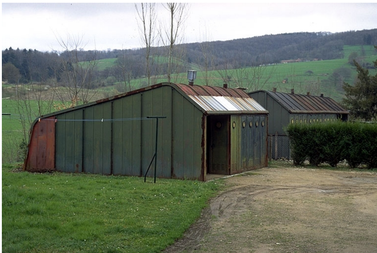
Remises d'automobile métallique : vue d'ensemble.
