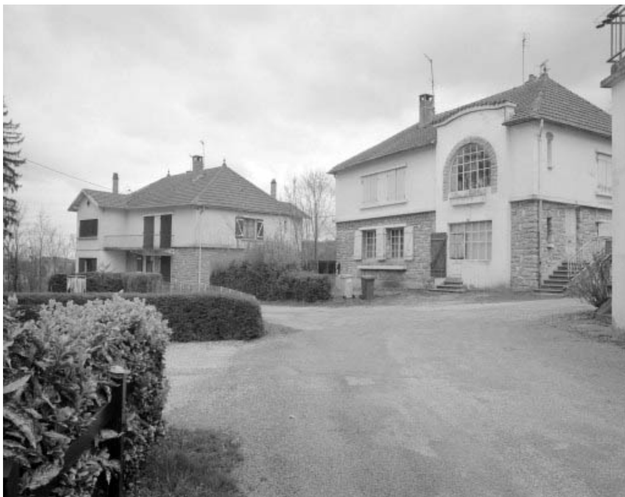
Maisons (G, D) : vue d'ensemble.
