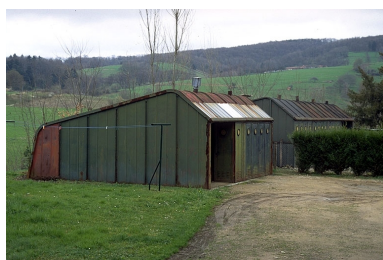
Remises d'automobile métallique : vue d'ensemble. Phot. Yves Sancey IVR43_19943901643ZA
