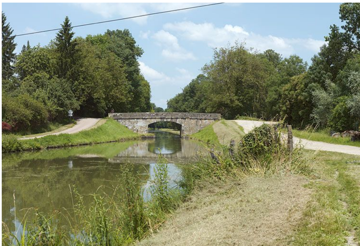
Le pont : vue de face.
