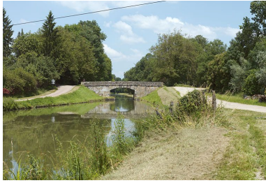
Le pont : vue de face. Phot. Thierry Kuntz IVR26_20135800274NUC4A
